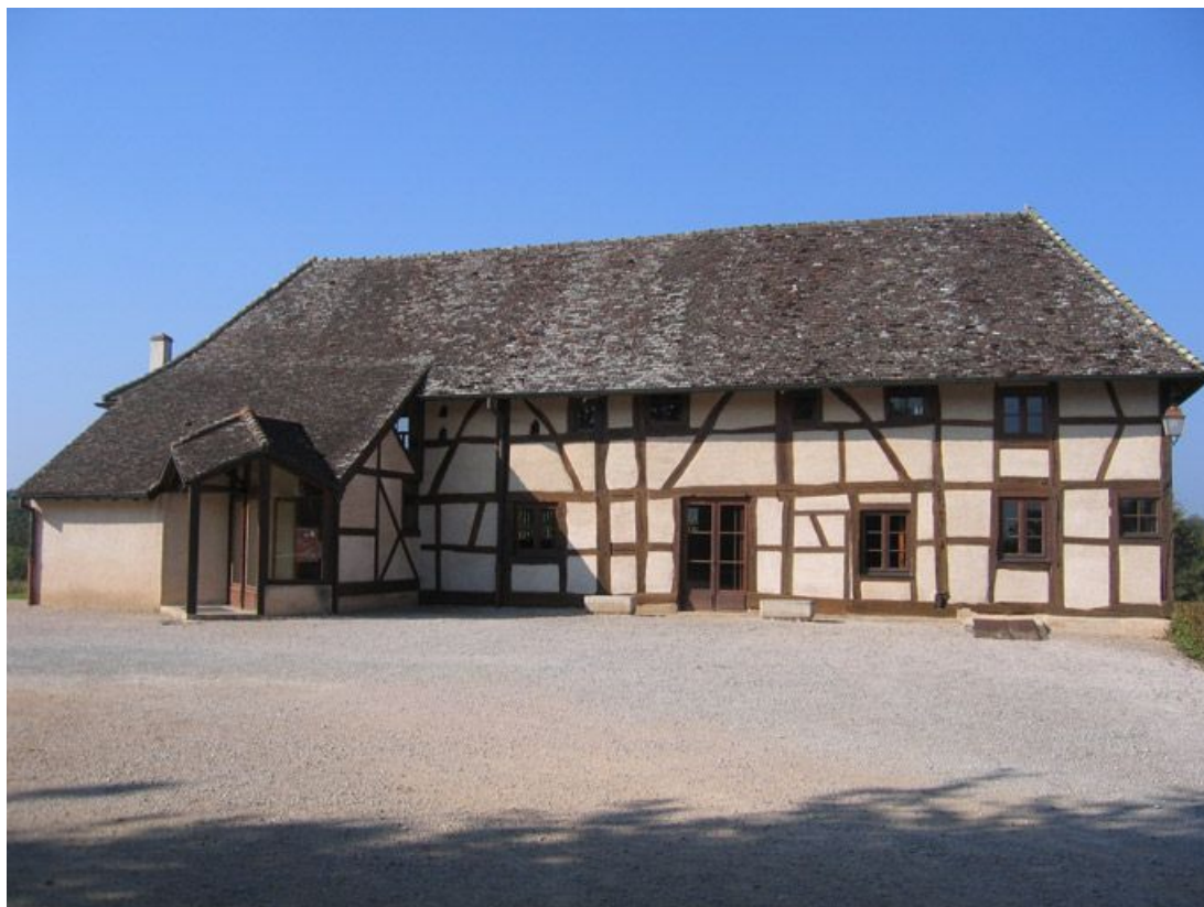
Vue d'ensemble de la façade.
