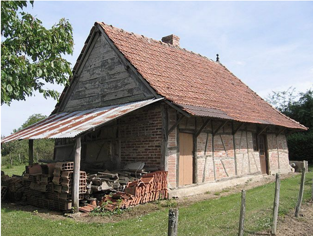
Vue d'ensemble de la façade.
