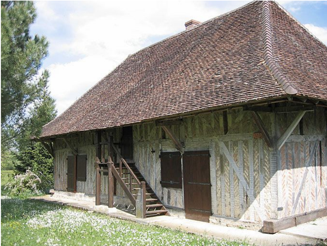
Vue d'ensemble de la façade.
