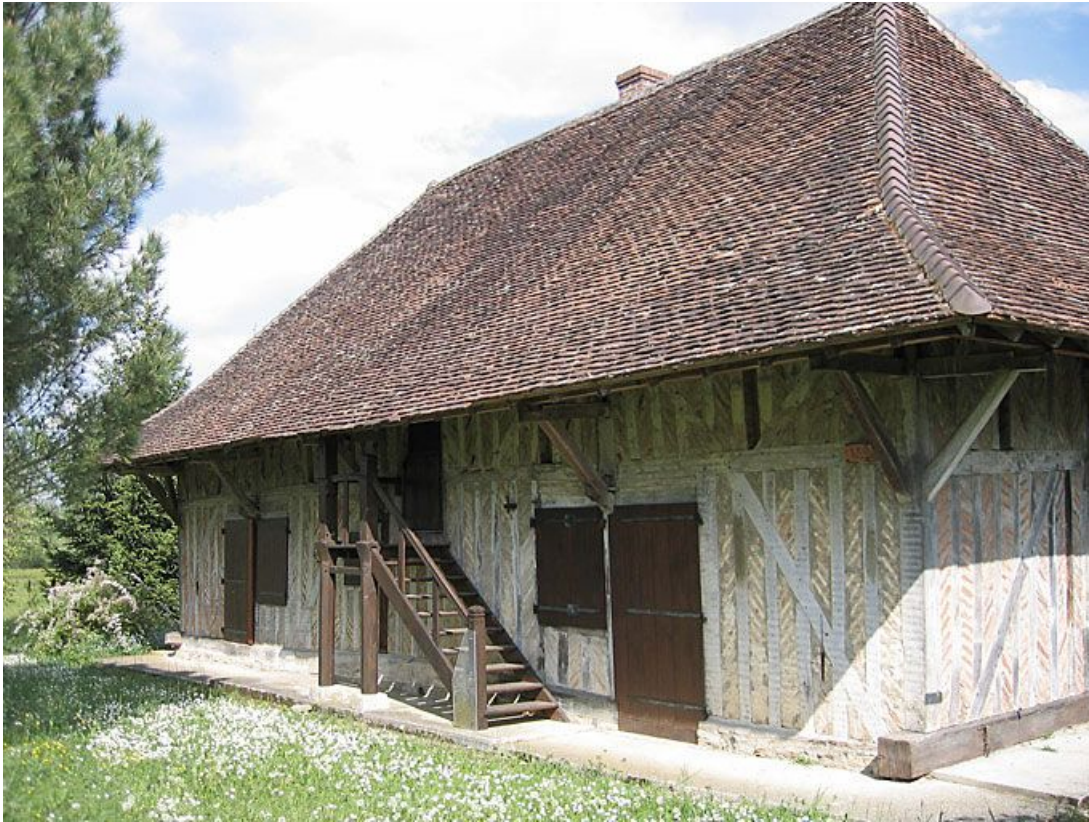
Vue d'ensemble de la façade.
