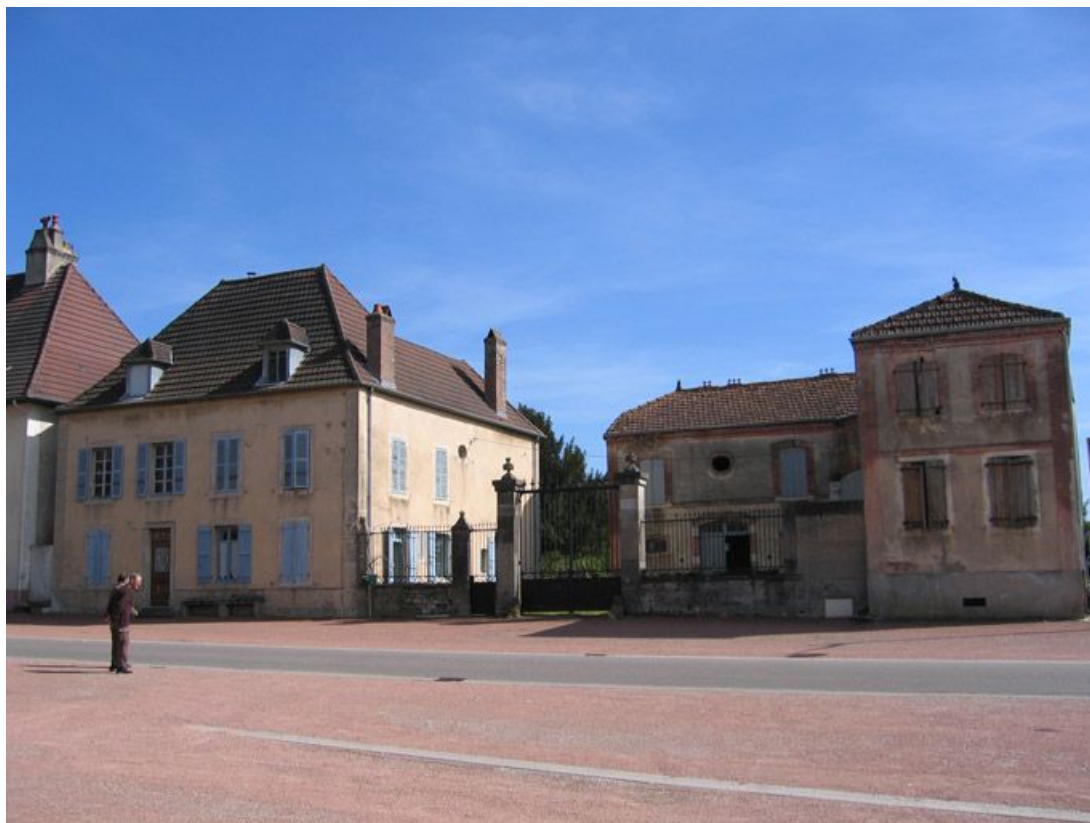
Vue d'ensemble de la façade.
