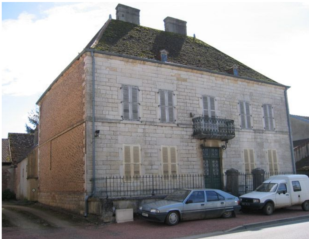
Vue d'ensemble de la façade.
