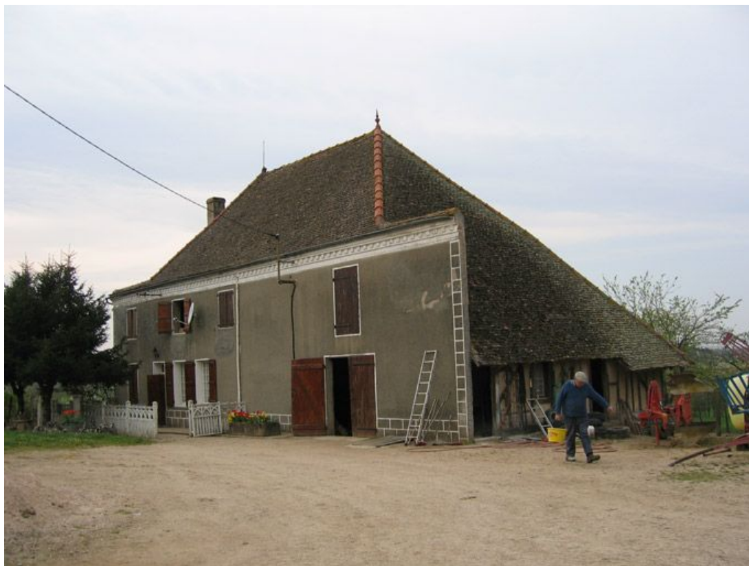
Vue d'ensemble de la façade.
