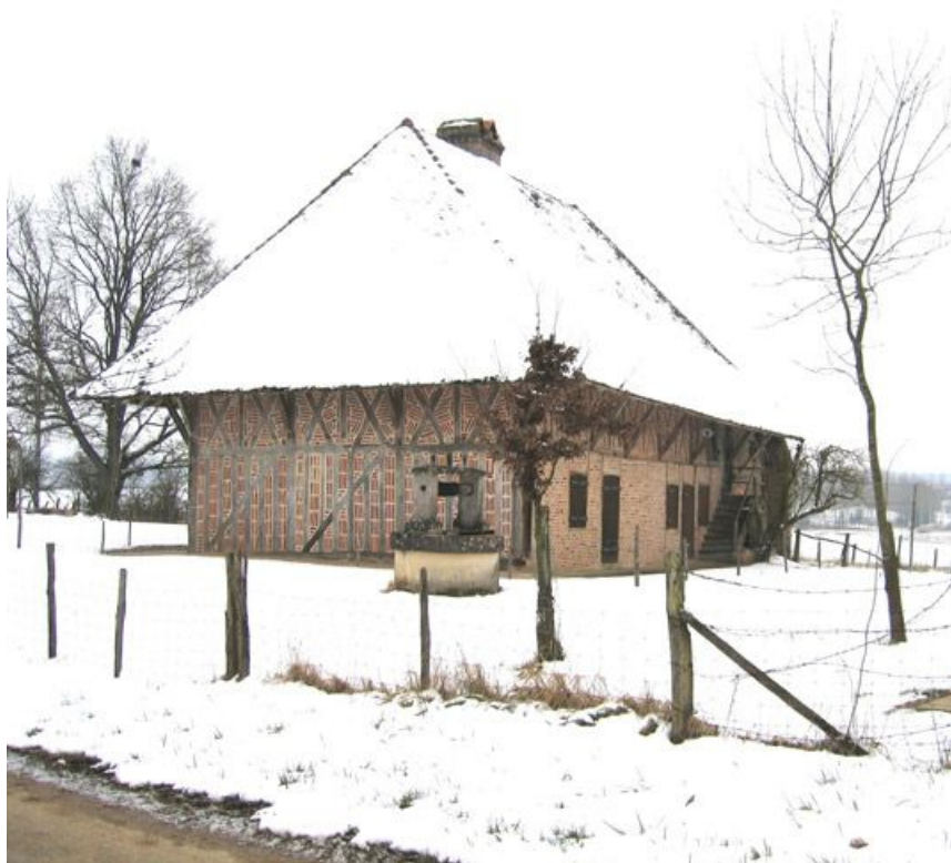
Vue d'ensemble de la façade de l'habitation.
