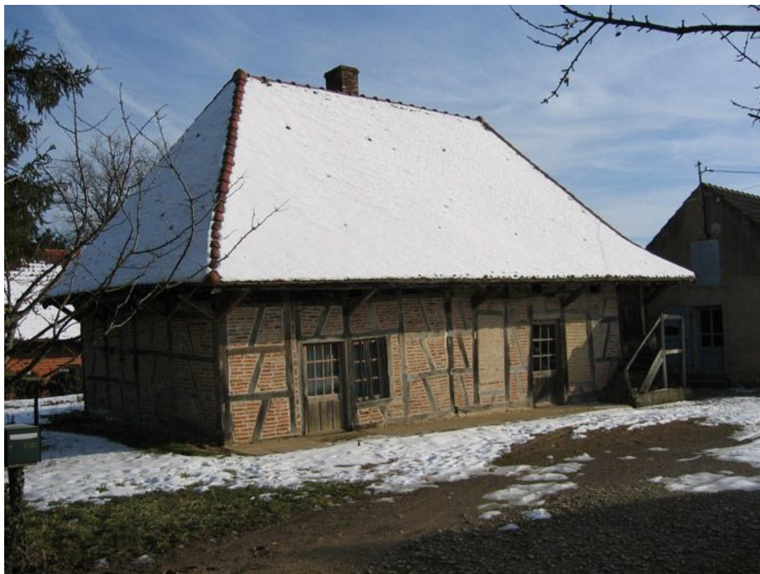
Vue d'ensemble de la façade.
