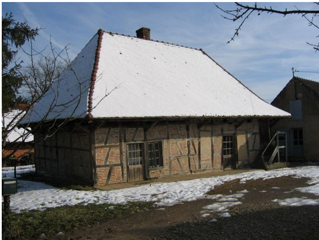
Vue d'ensemble de la façade.
