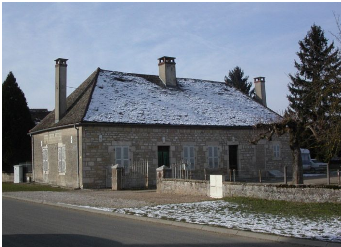
Vue d'ensemble de la façade.
