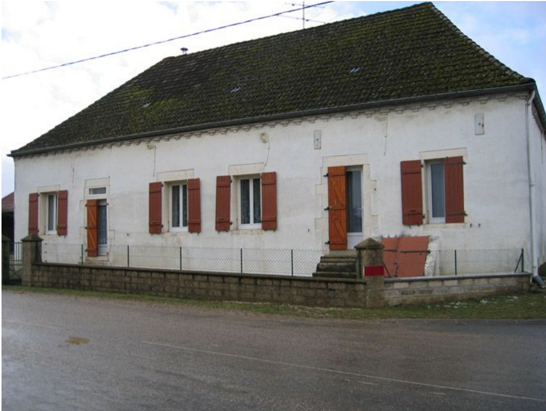
Vue d'ensemble de la façade.
