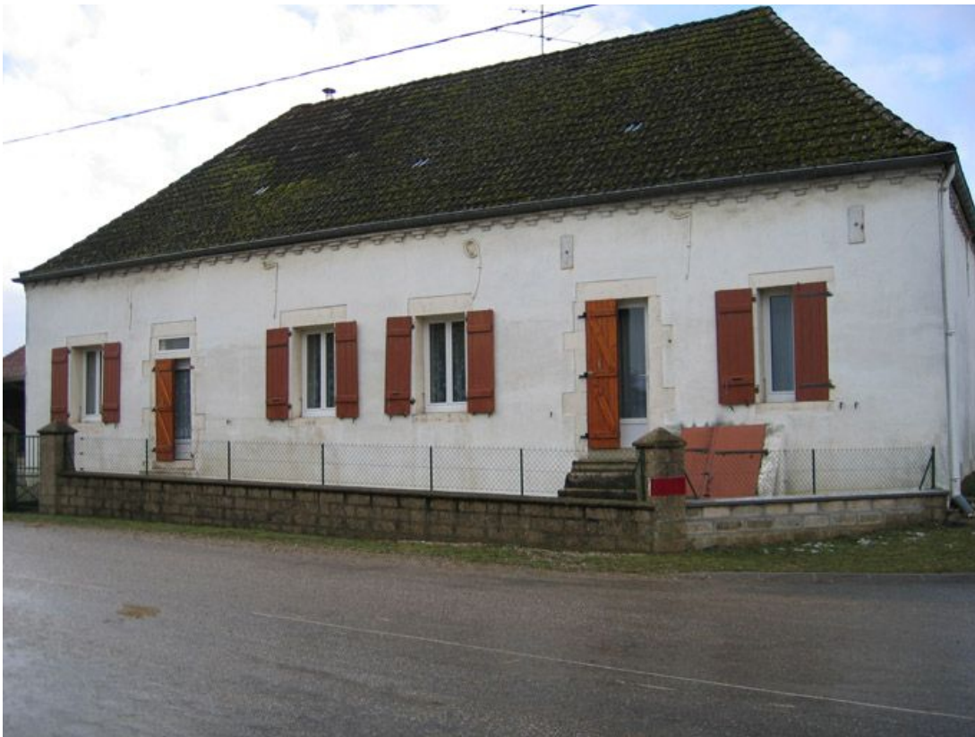
Vue d'ensemble de la façade.
