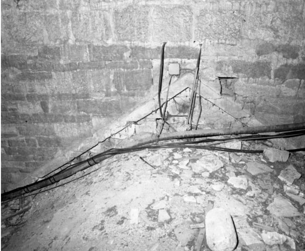
Rampants du pignon de l'ancien toit du chœur contre le mur postérieur du clocher. Vue prise dans le comble du chœur. 71, Saint-Loup-Géanges Joseph Delissey, lieudit : Saint-Loup-de-la-Salle
