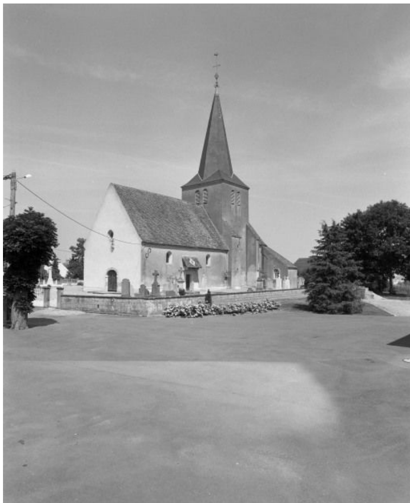
Vue d'ensemble : façade et élévation droite.
