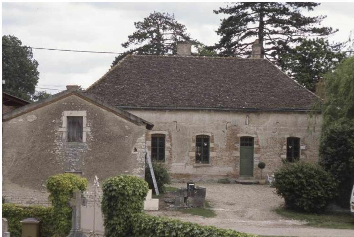
Vue d'ensemble. 71, Pontoux Eglise
