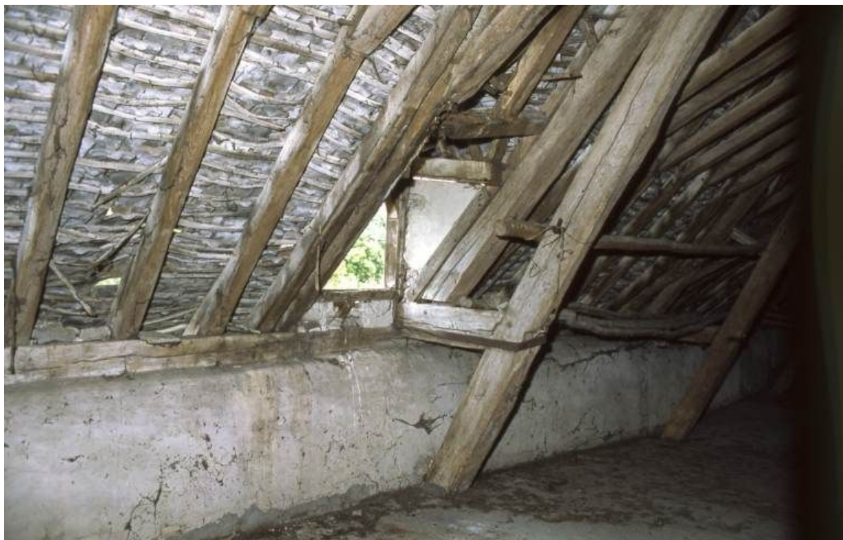
Logis secondaire, lucarne du comble vue de l'intérieur.
