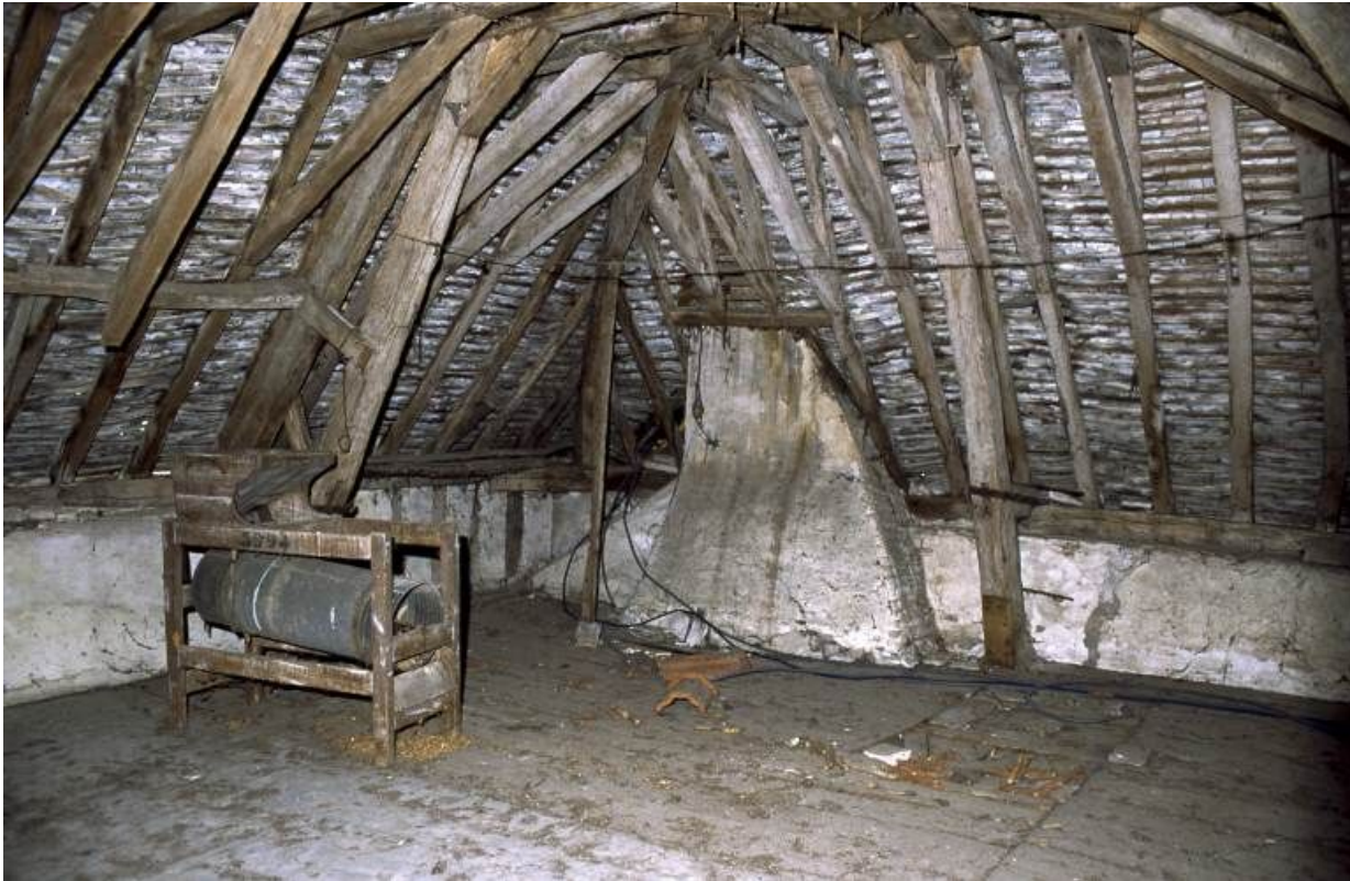
Logis secondaire, angle droit du comble avec conduit de cheminée.
