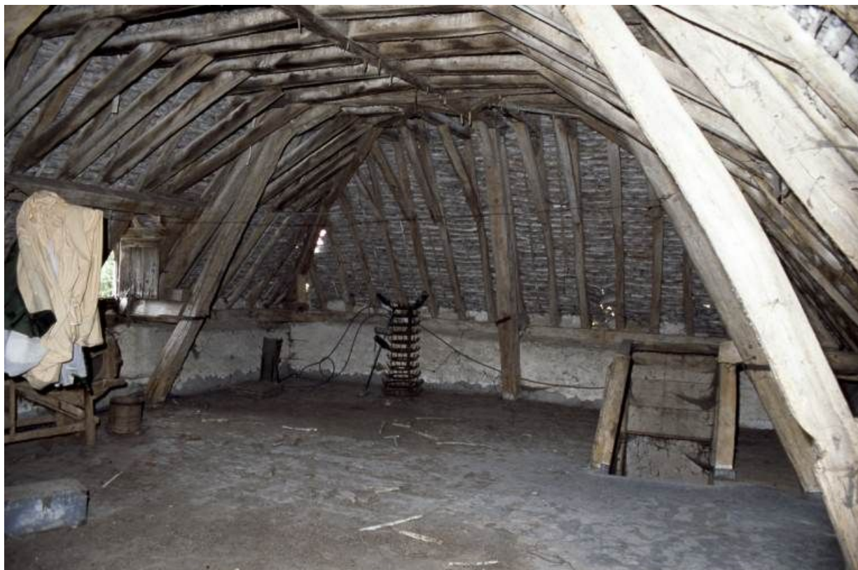
Logis secondaire, partie droite du comble.
