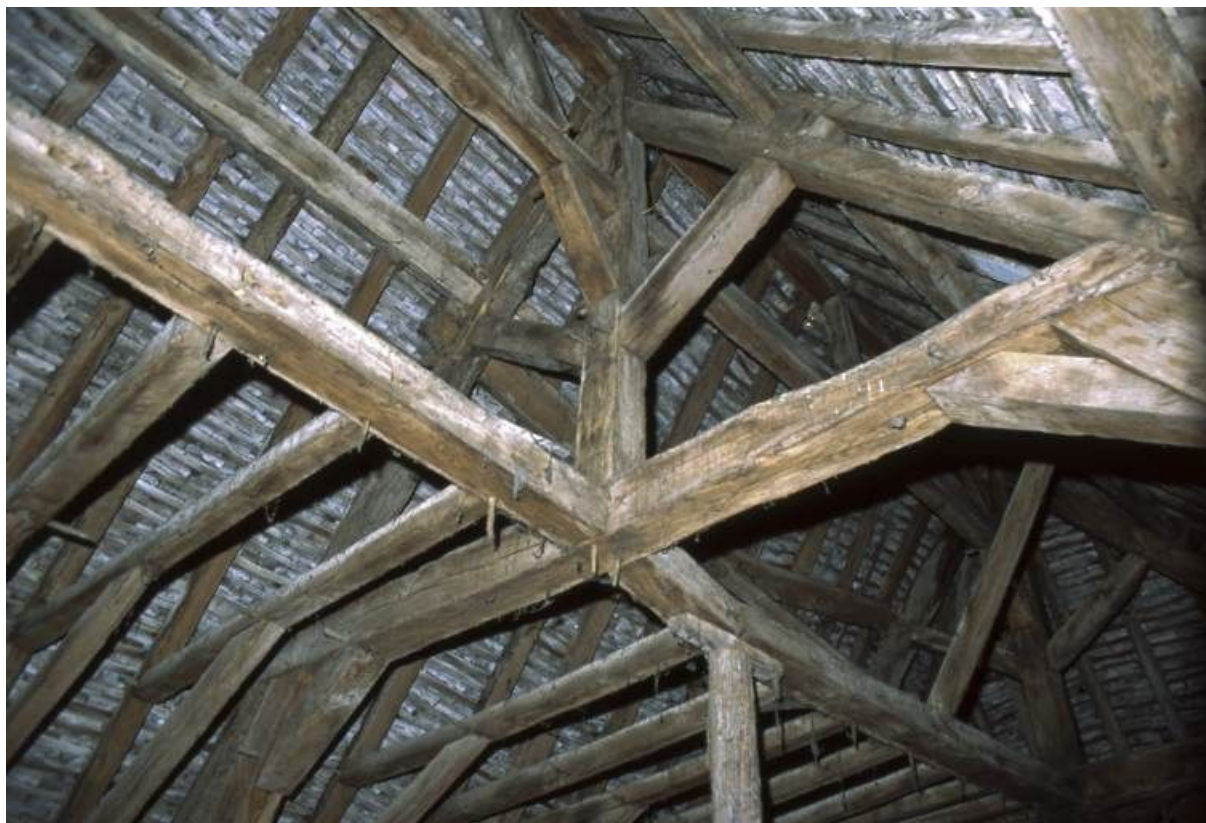
Logis secondaire, partie supérieure de la charpente.
