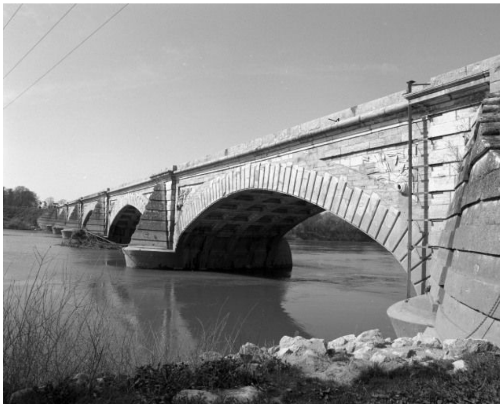
Vue d'ensemble rapprochée, en amont. 71, Navilly R.N. 73
