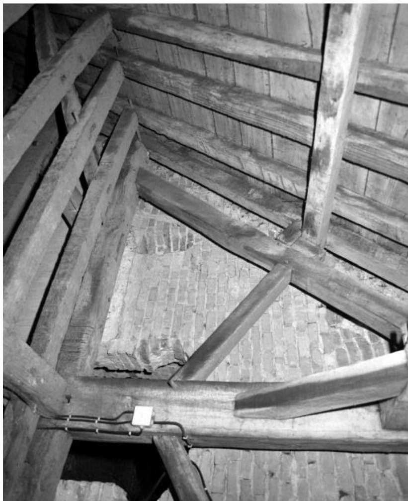
Comble : mur avec petite niche entre la nef et le choeur.
