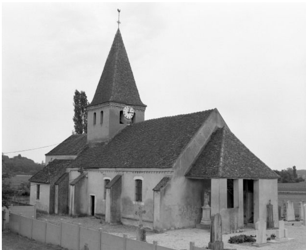
Vue d'ensemble : porche antérieur et élévation gauche.
