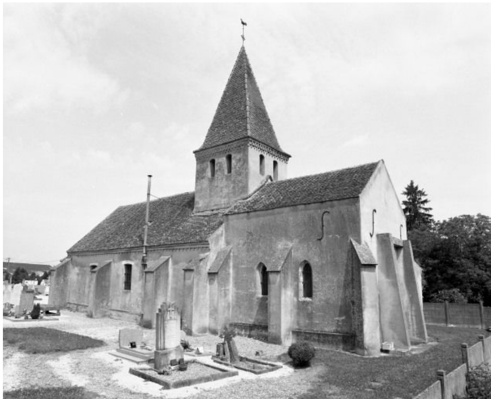
Vue d'ensemble : élévation droite et chevet.
