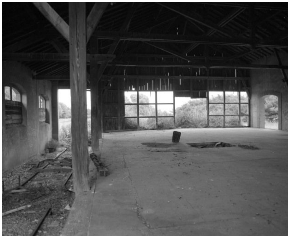
Gare de marchandises, intérieur.
