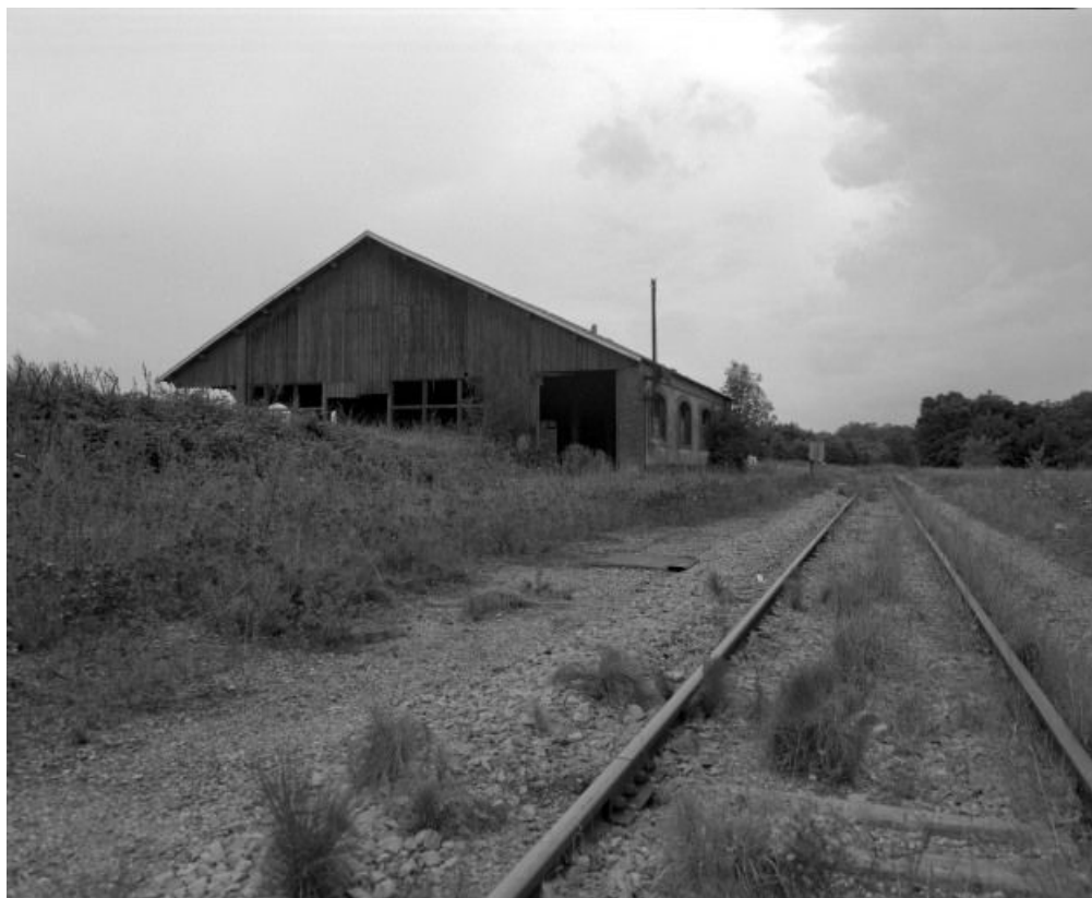
Gare de marchandises, pignon en bois.
