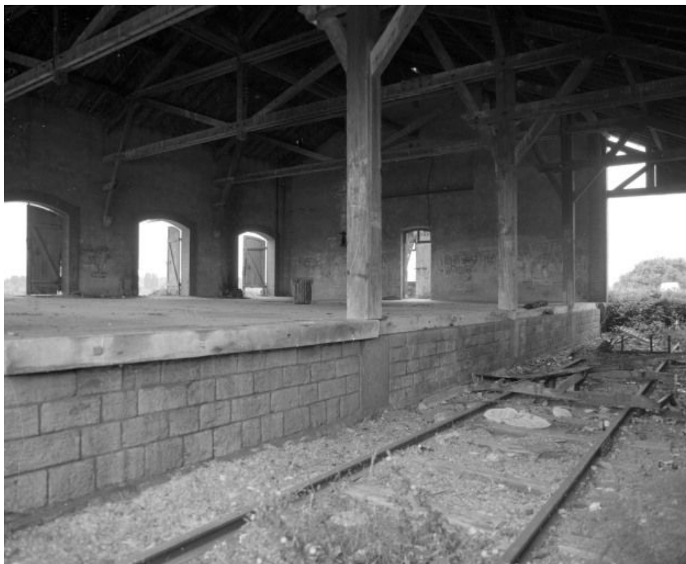
Gare de marchandises, intérieur.
