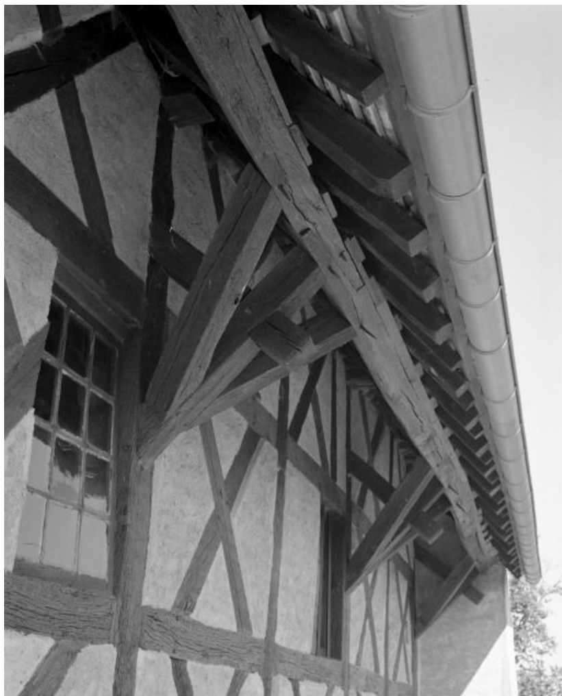
Élévation gauche de la nef, détail.
