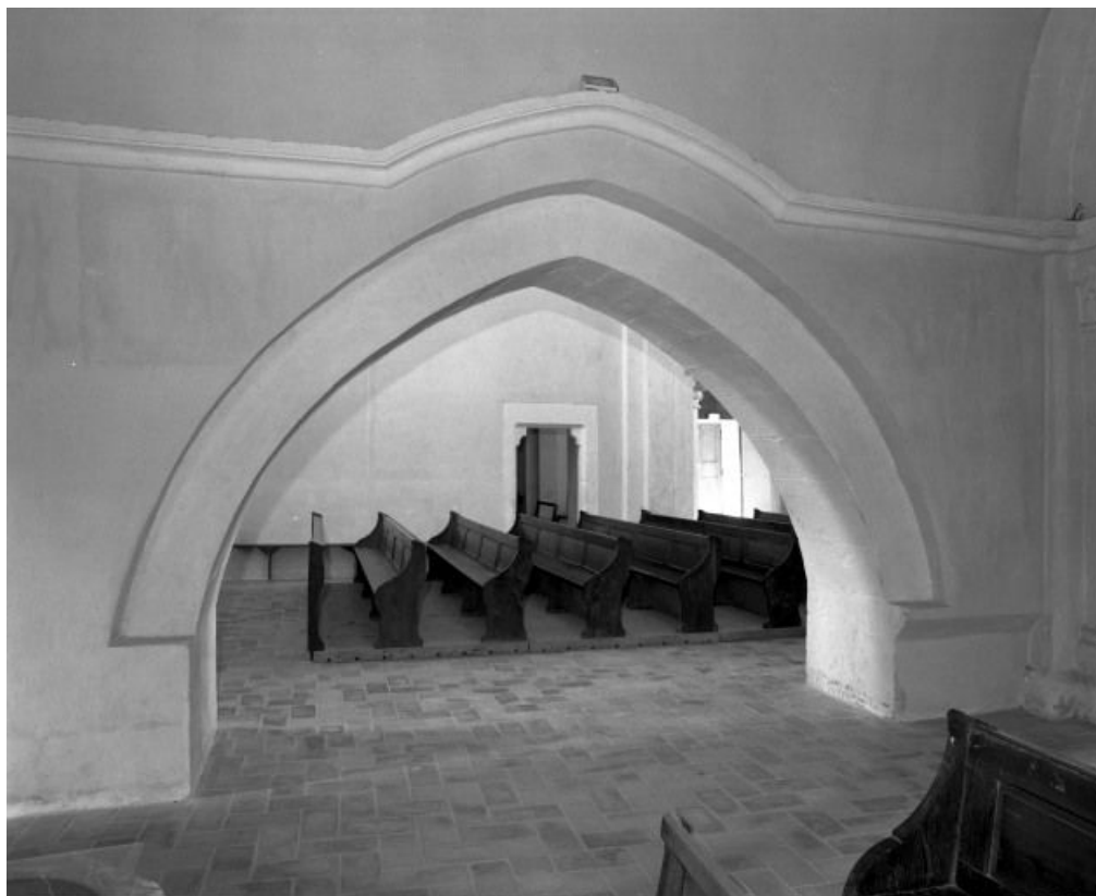
Chapelle gauche (nord), arcade brisée ouvrant sur l'avant-choeur. 71, Gergy Eglise
