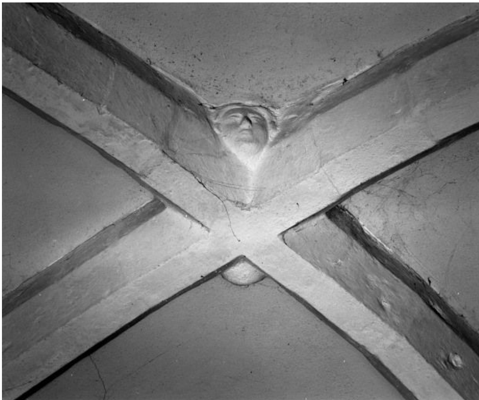
Bas-côté droit (sud), détail de la voûte. 71, Gergy Eglise
