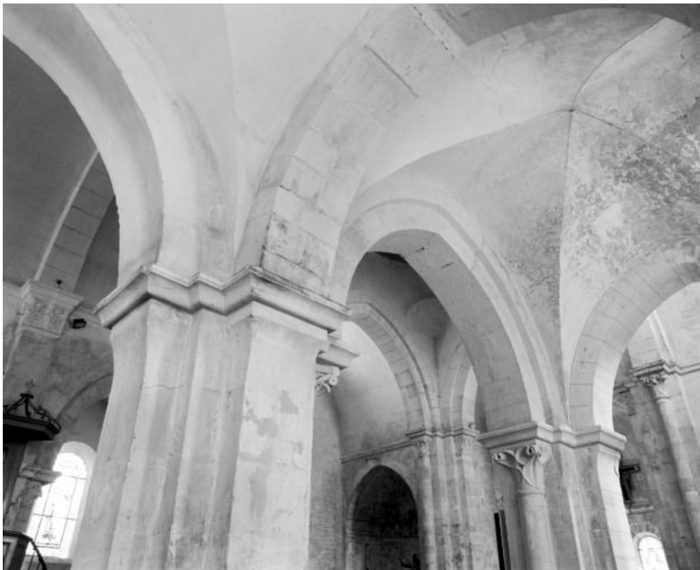
Bas-côté droit, 4e travée : angle nord-ouest, vestige d'un départ d'arc formeret. 71, Ciel C.D. 72
