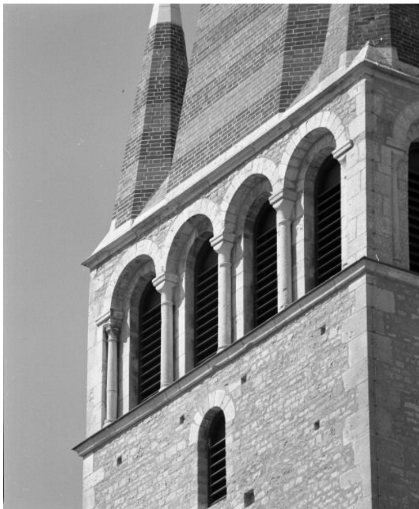
Clocher : détail des baies de la face postérieure.
