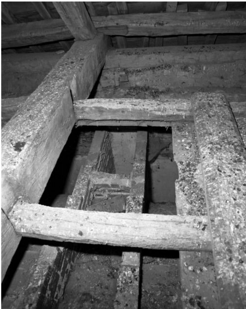
Comble du vaisseau central de la nef : double muret de brique au niveau des arcs doubleaux. 71, Ciel C.D. 72
