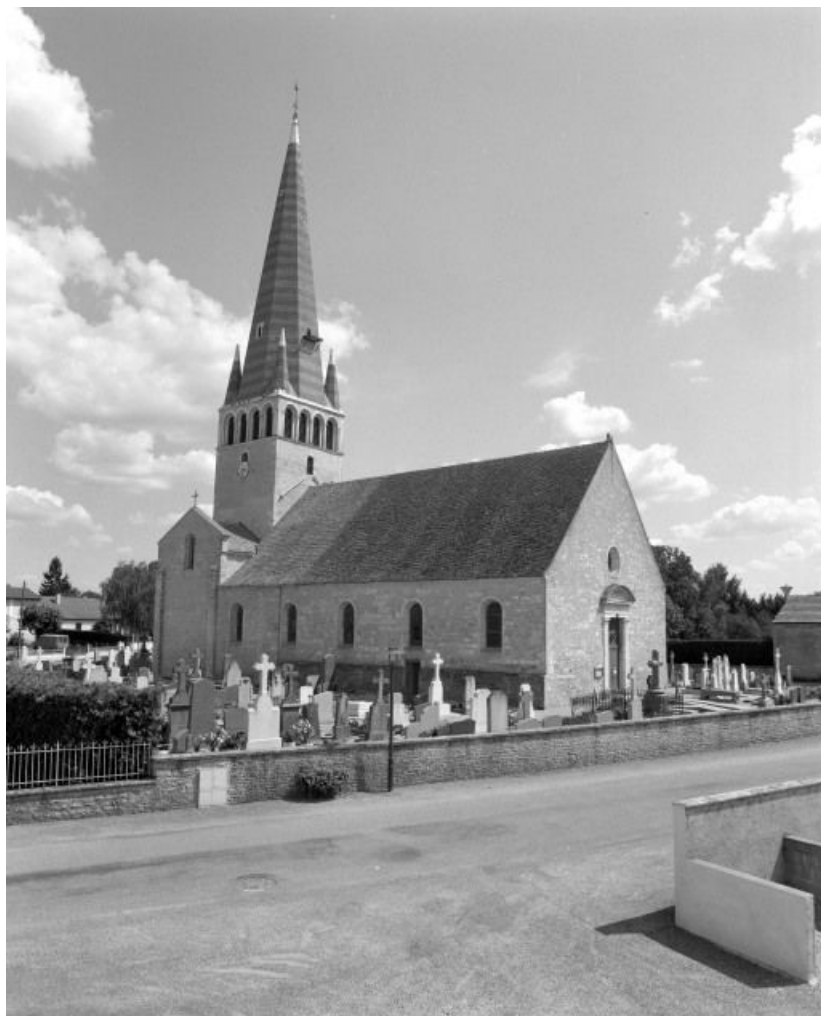
Vue d'ensemble : façade et élévation gauche.
