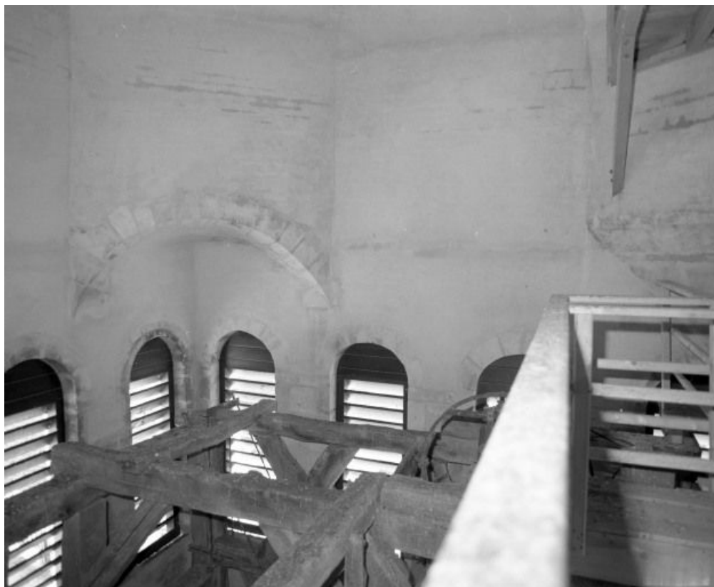
Intérieur du clocher, angle antérieur droit.
