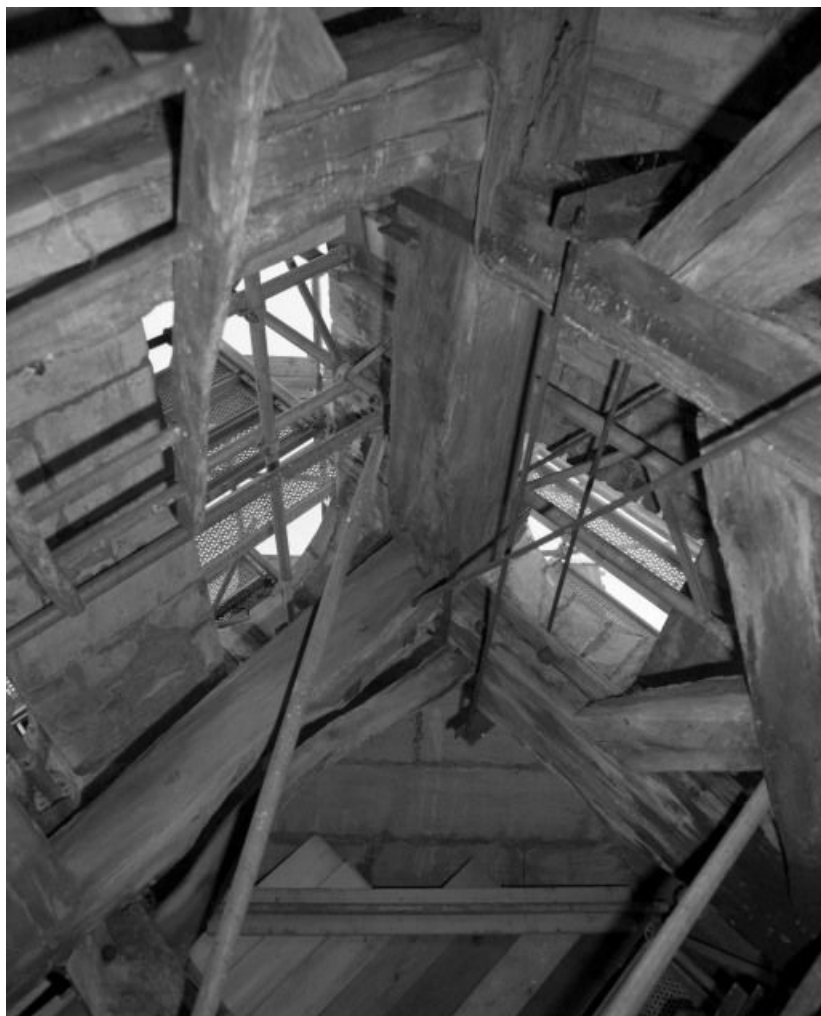
Clocher : support en ciment dans l'angle sud-ouest (vue prise pendant les travaux). 71, Ciel C.D. 72
