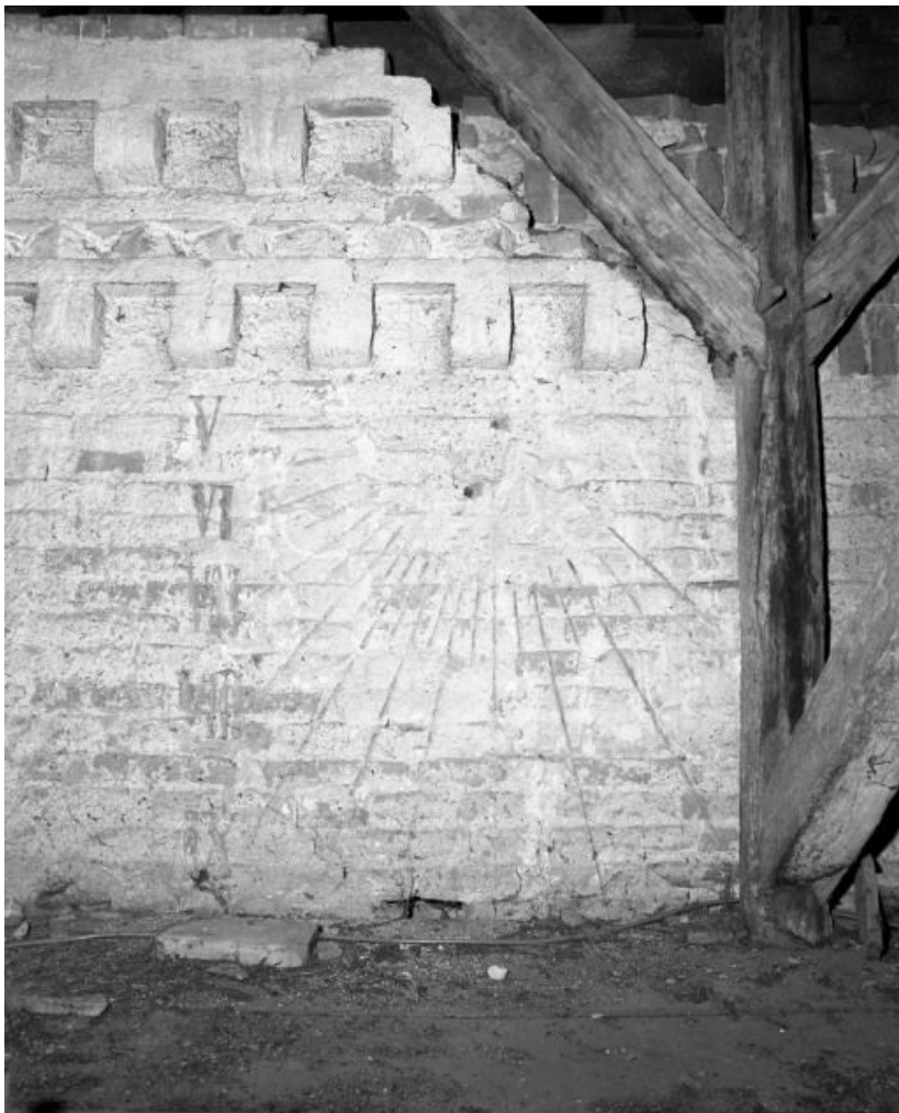
Comble de la chapelle droite : cadran solaire.
