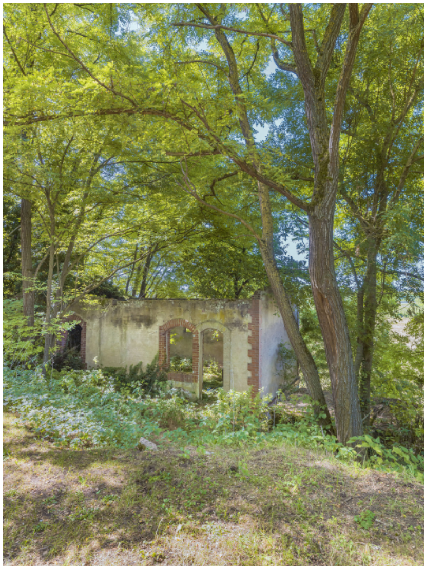
Vestiges d'un bâtiment (magasin ?), rive gauche.
