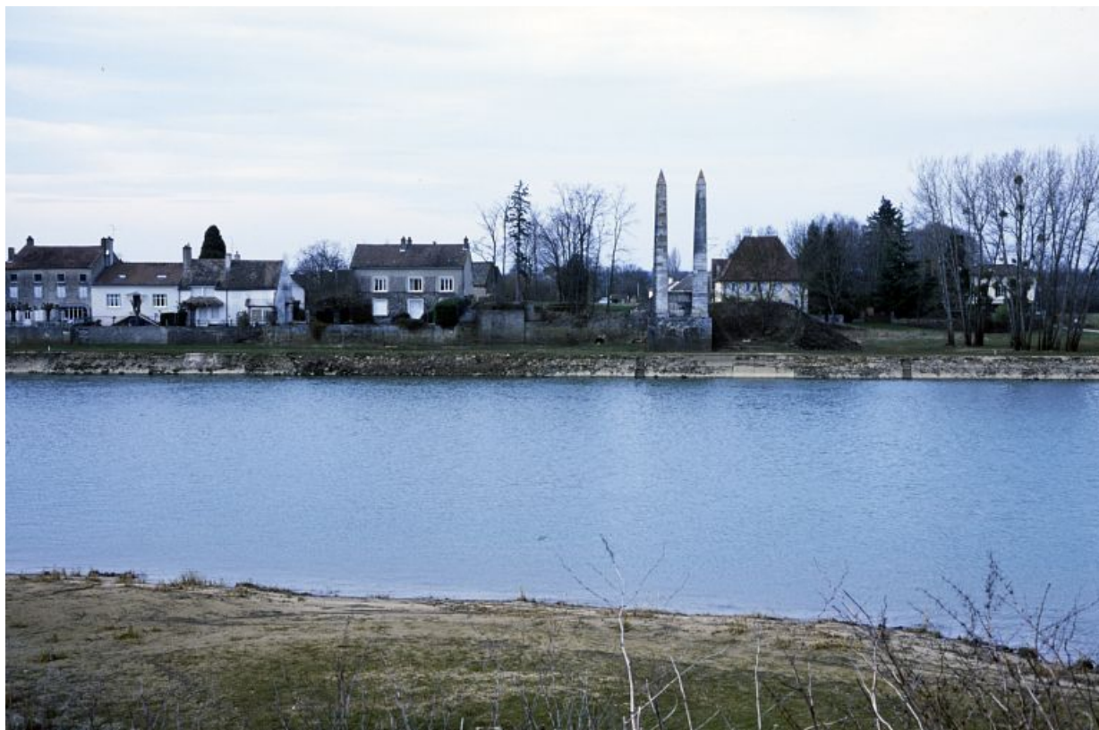
Pylônes, vestiges du pont suspendu en 2003.
