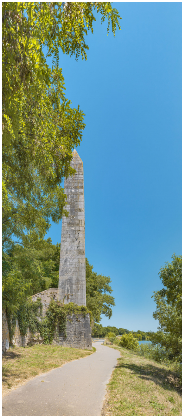
Pylônes de la rive droite, le long de la digue de Chauvort.
