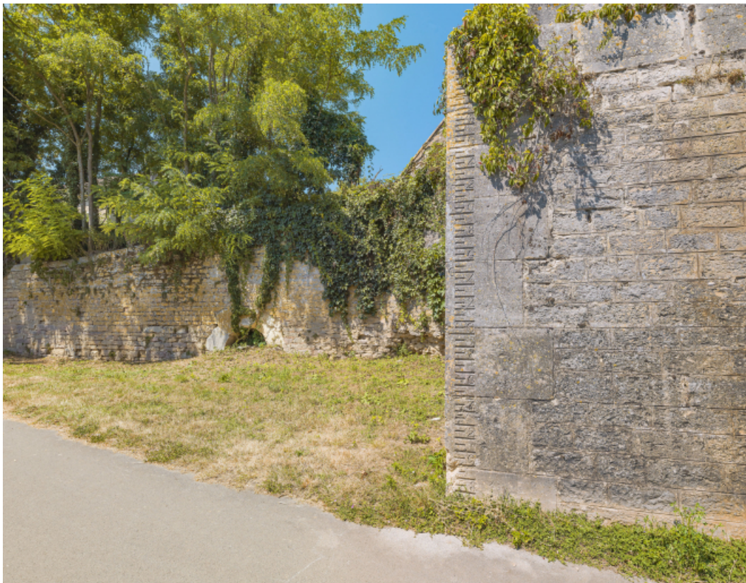
Détail de l'échelle de crue sur le pylône de la rive droite.
