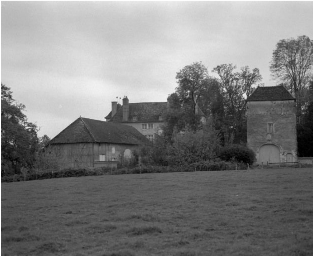
Vue d'ensemble prise du nord.
