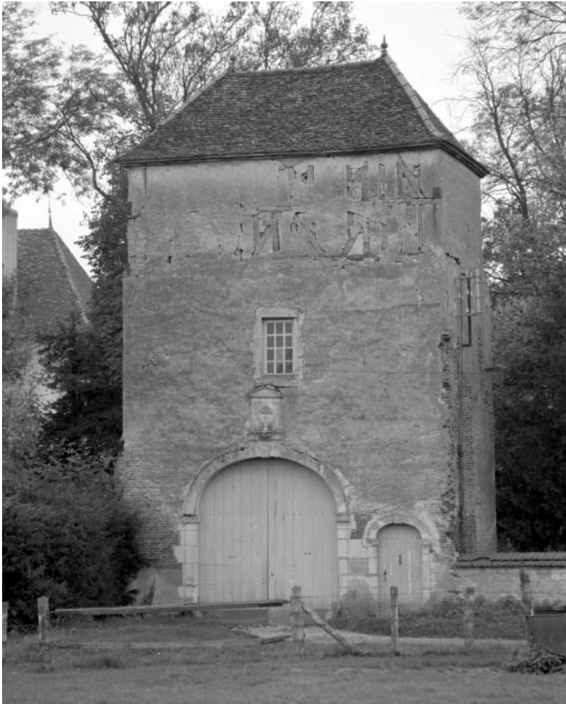
Corps de passage avec niche datée 1669. 71, Gergy Château
