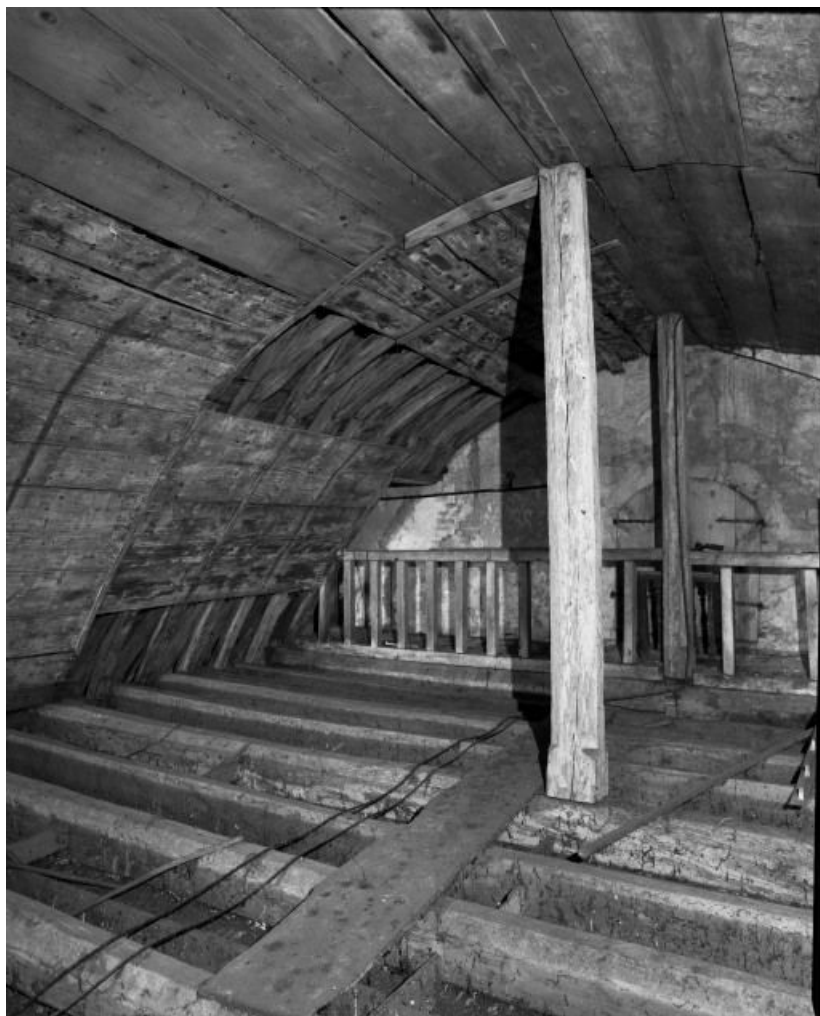
Comble de la nef, vue prise depuis le revers de façade.
