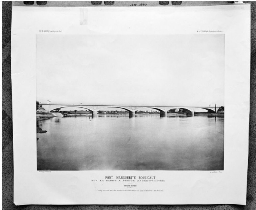
PONT MARGUERITE BOUCICAUD / sur la Saône à Verjux (Saône-et-Loire) / 1888-1890 / cinq arches de 40 mètres d'ouverture et de 5 mètres de flèche..
