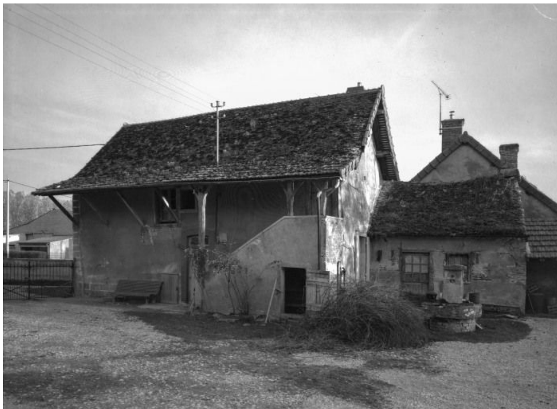
Bâtiment d'habitation et chambre à four.
