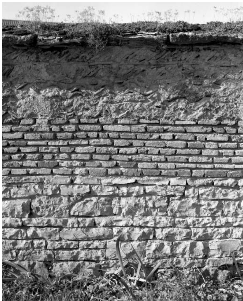
Détail d'un mur de clôture.
