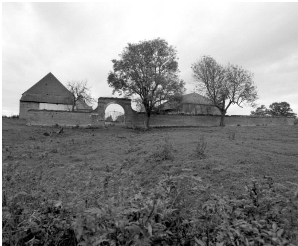
Vue d'ensemble prise du sud, côté du portail postérieur de la cour.
