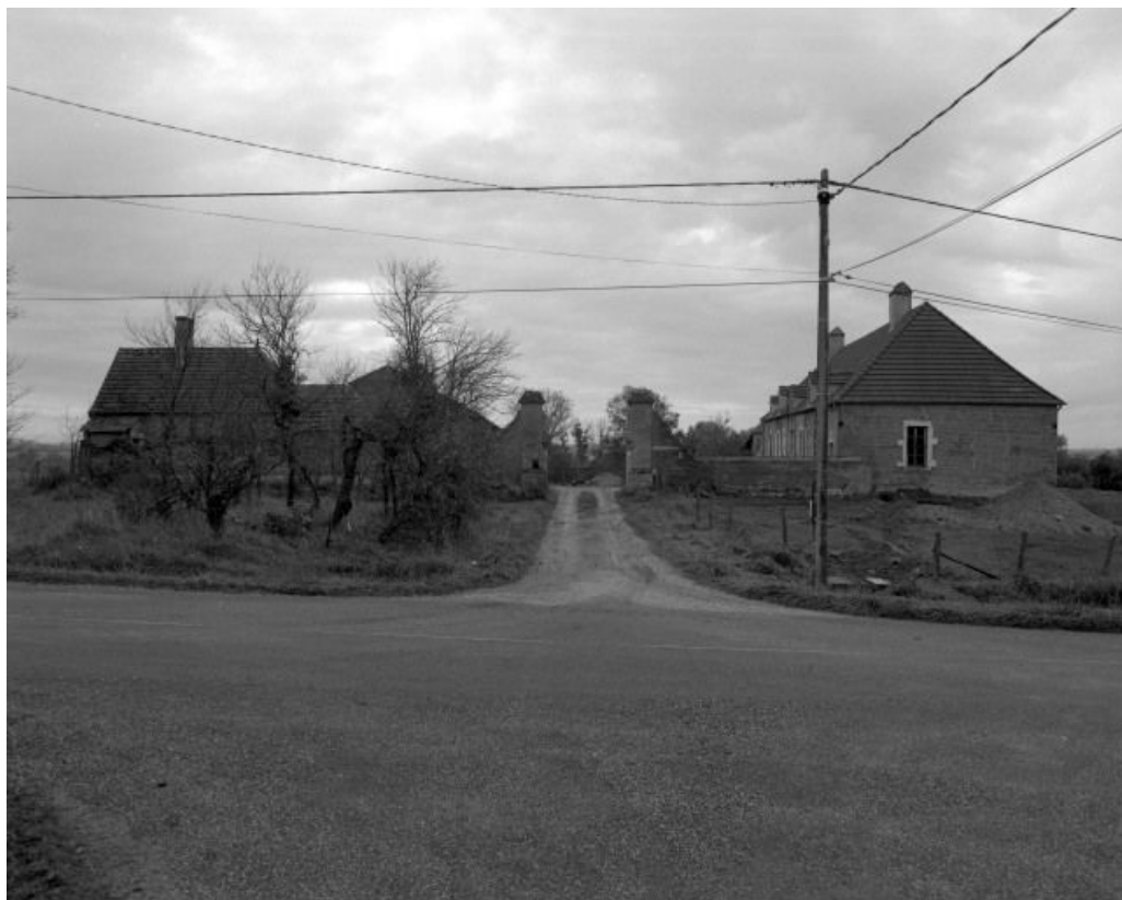
Vue d'ensemble prise du nord, côté du portail antérieur de la cour.
