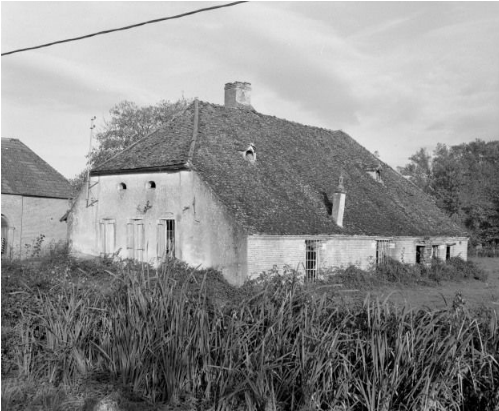
Logis : élévations droite et postérieure.
