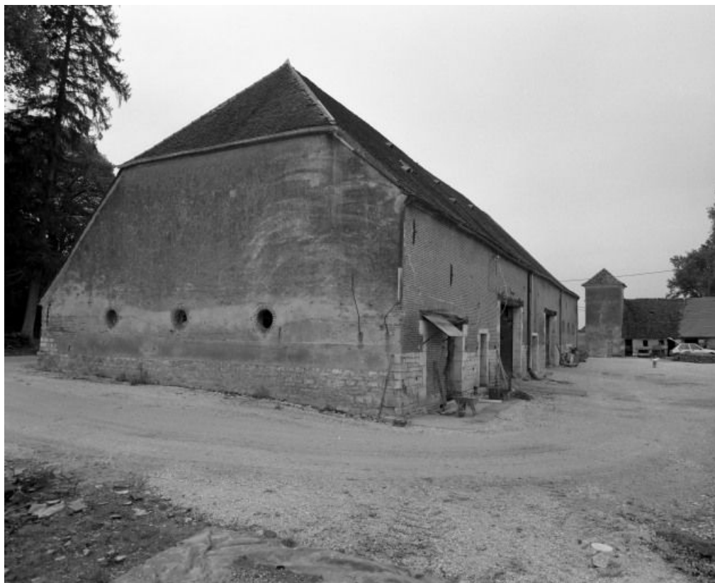
Élévations sud et est du grand bâtiment de dépendances.
