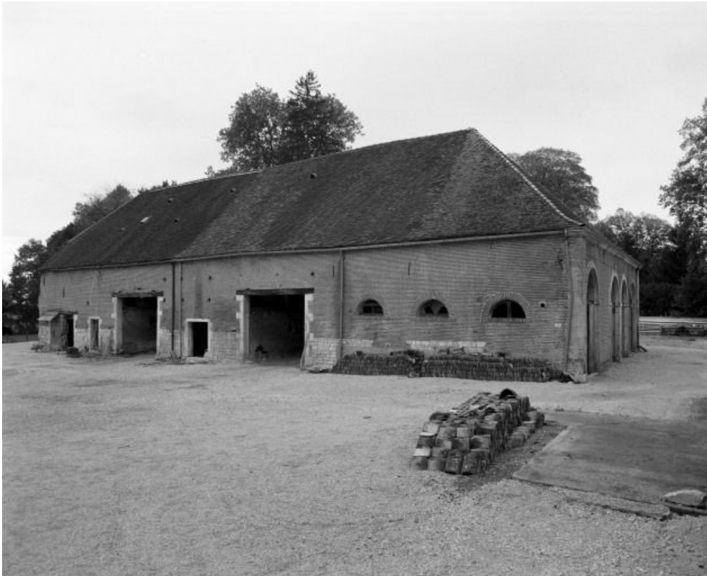
Élévations est et nord du grand bâtiment de dépendances.
