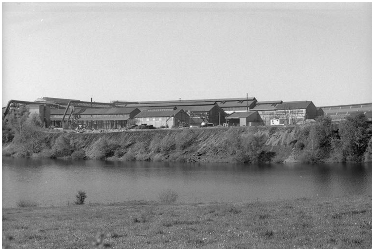
Vue de l'aciérie depuis le nord-est.
