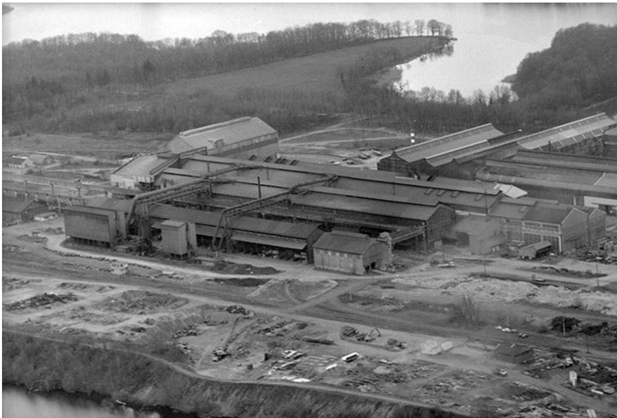
Vue aérienne de l'aciérie depuis le nord-est.
