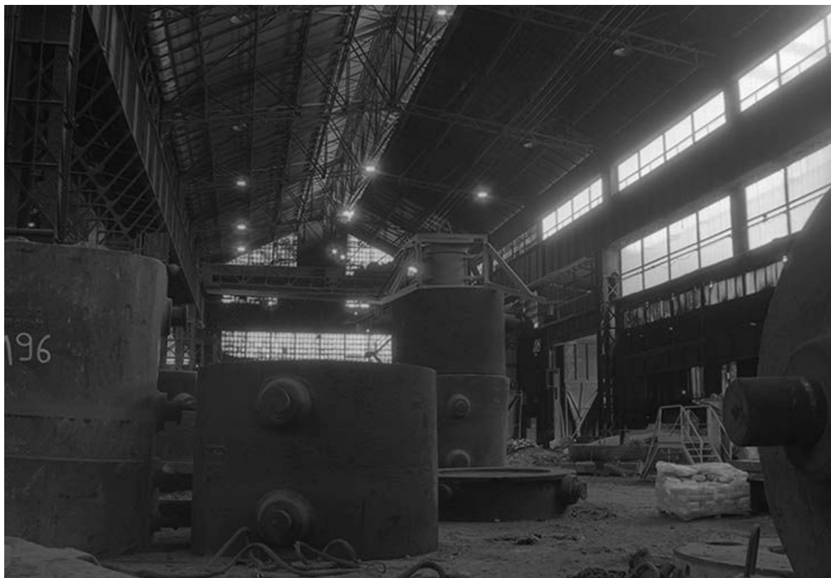
Extrémité nord de la halle des fours.
