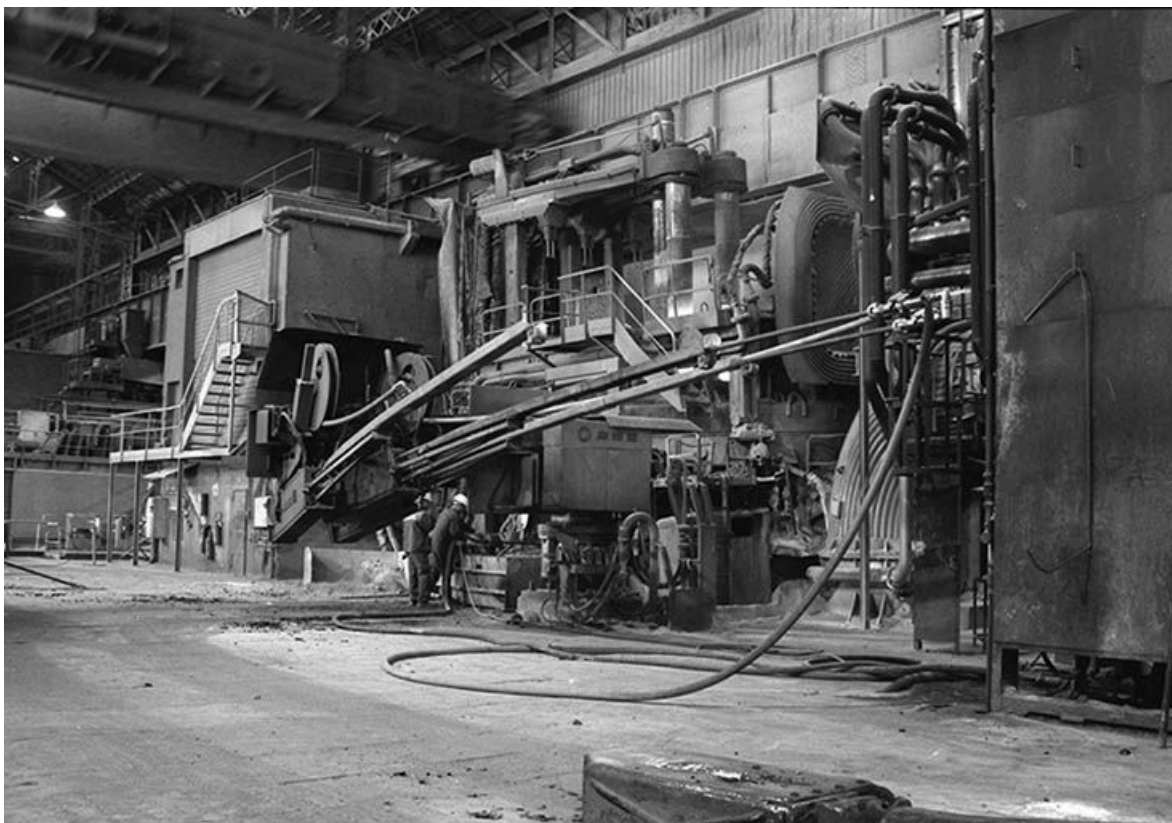
Le four électrique de 100 tonnes en activité.
