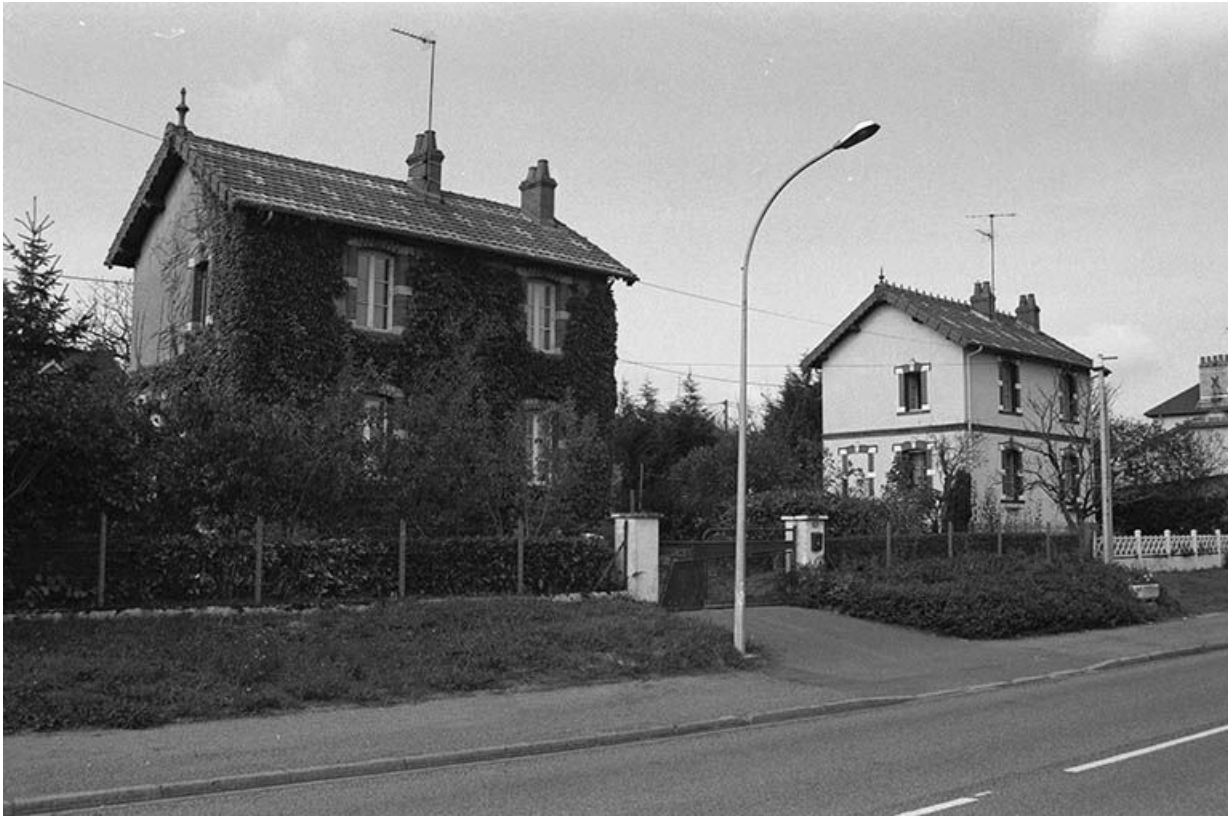
Bâtiments à un seul logement construits en 1930-33, vus depuis le sud (68-69 route du Canal). 71, Écuisses, 66.76 route du Canal, lieudit : la Rompey
