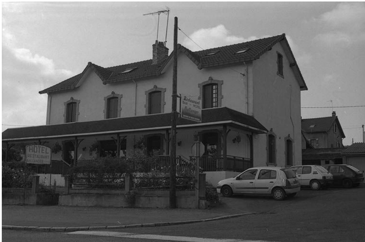
Façade antérieure (route du Canal) de l'ancien café-épicerie.
