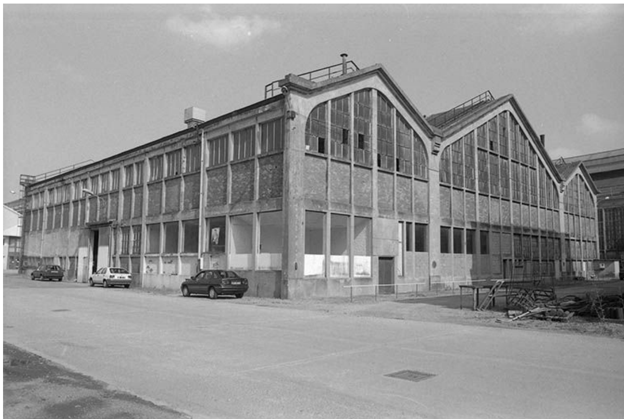
Magasin, vestiaires et douches vus de l'ouest.
