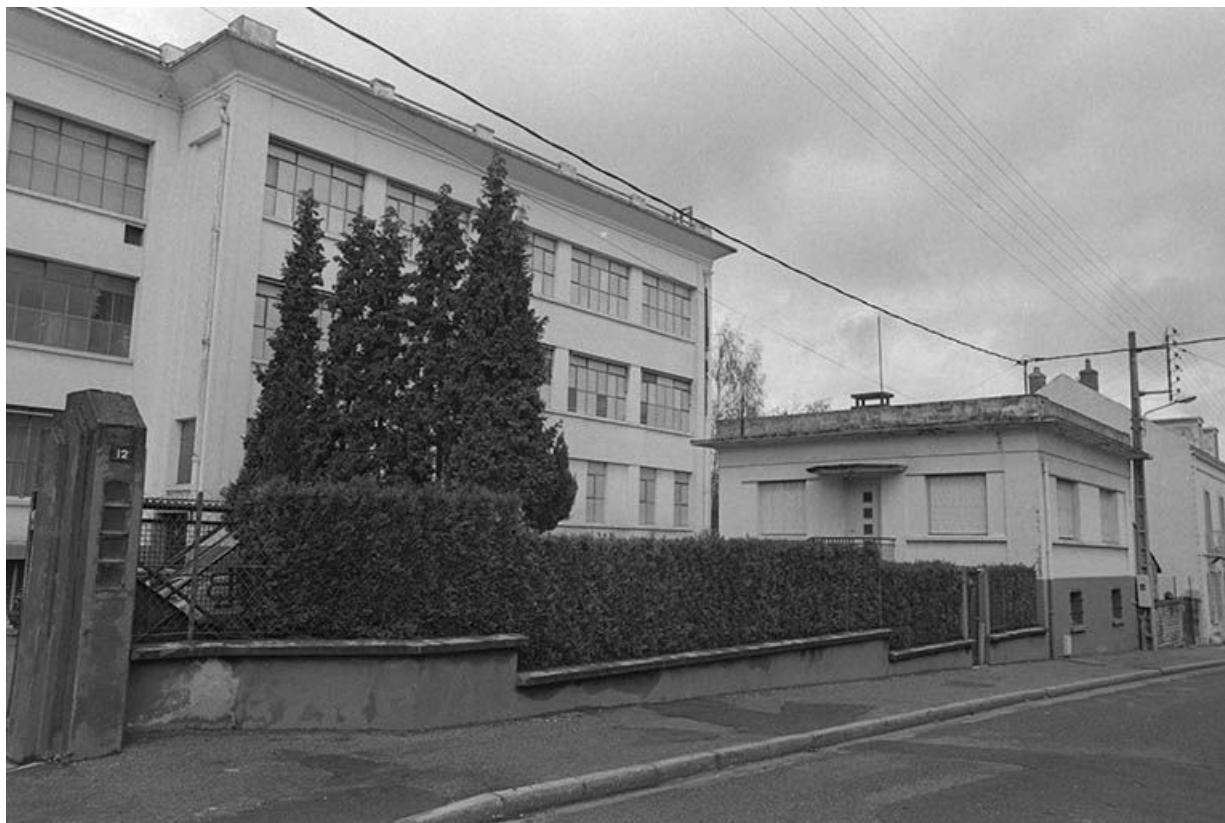
Vue de l'extension des ateliers de 1955-56, depuis la rue des Prés.
