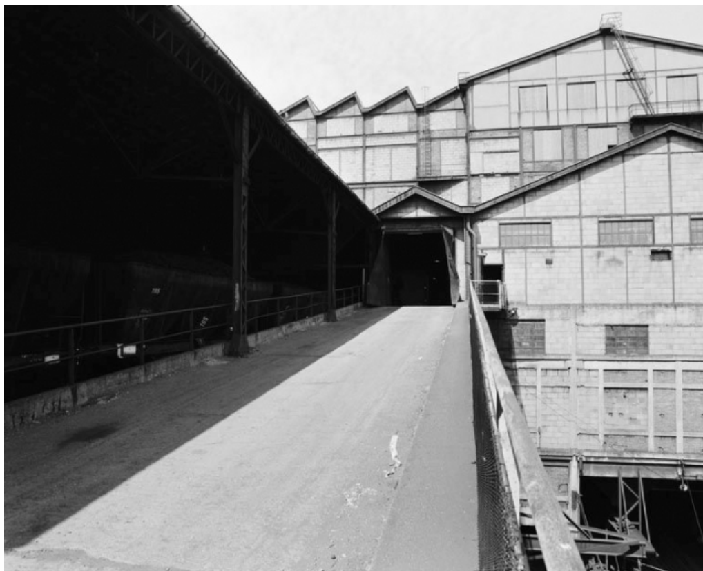
La rampe d'accès au lavoir des Chavannes.
