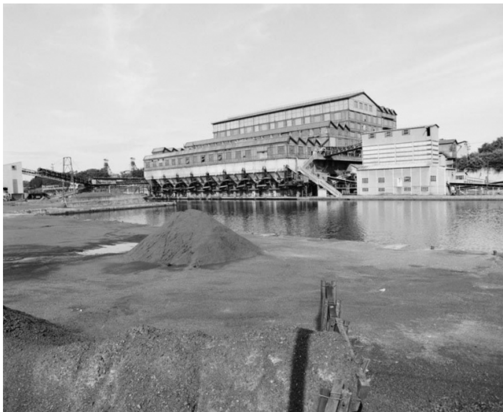
Vue depuis le quai du canal.
