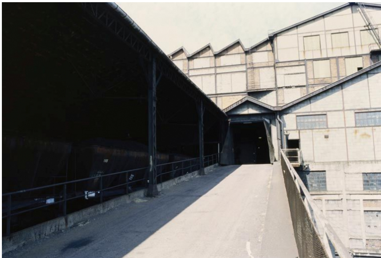
La rampe d'accès au lavoir des Chavannes.
