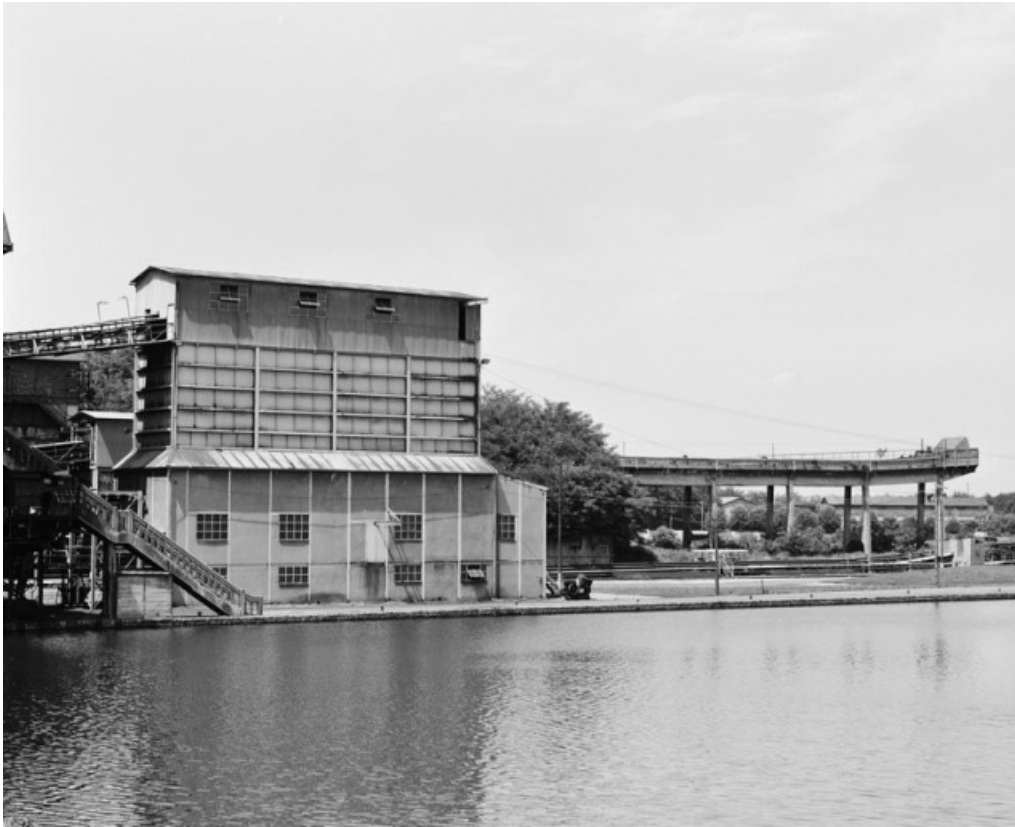
Silos (à gauche) et estacade de rebroussement des wagons après déchargement des produits bruts.
