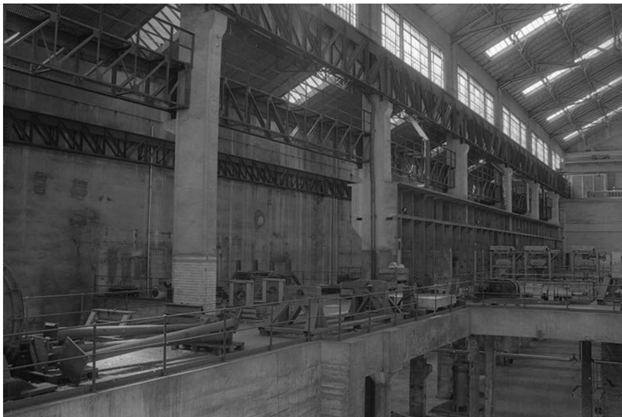
Le bâtiment des pompes vu depuis la salle des machines (ancienne plate-forme des turboalternateurs). 71, Montceau-les-Mines, 20 quai de Moulins
