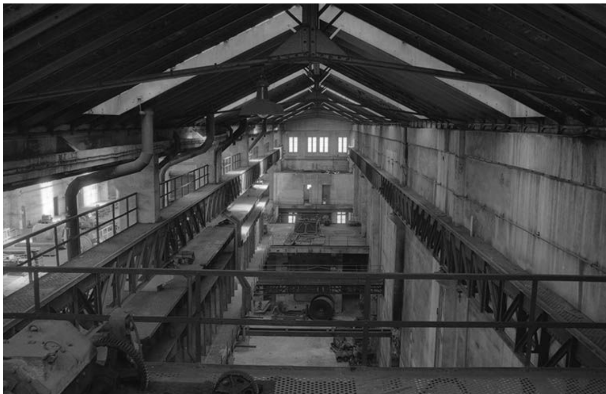
La salle des pompes photographiée depuis le pont roulant.
