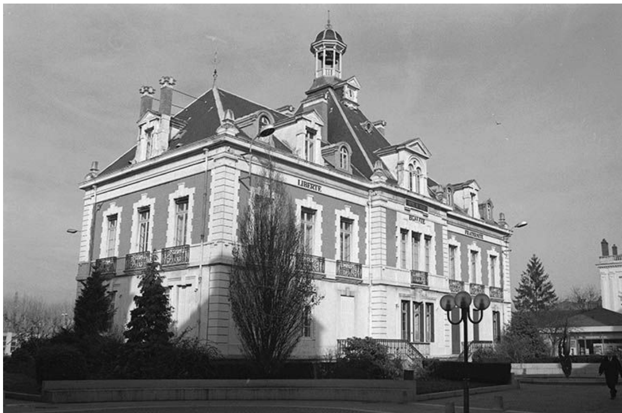
L'hôtel de ville de Montceau-les-Mines vu depuis le Sud (façade postérieure).
