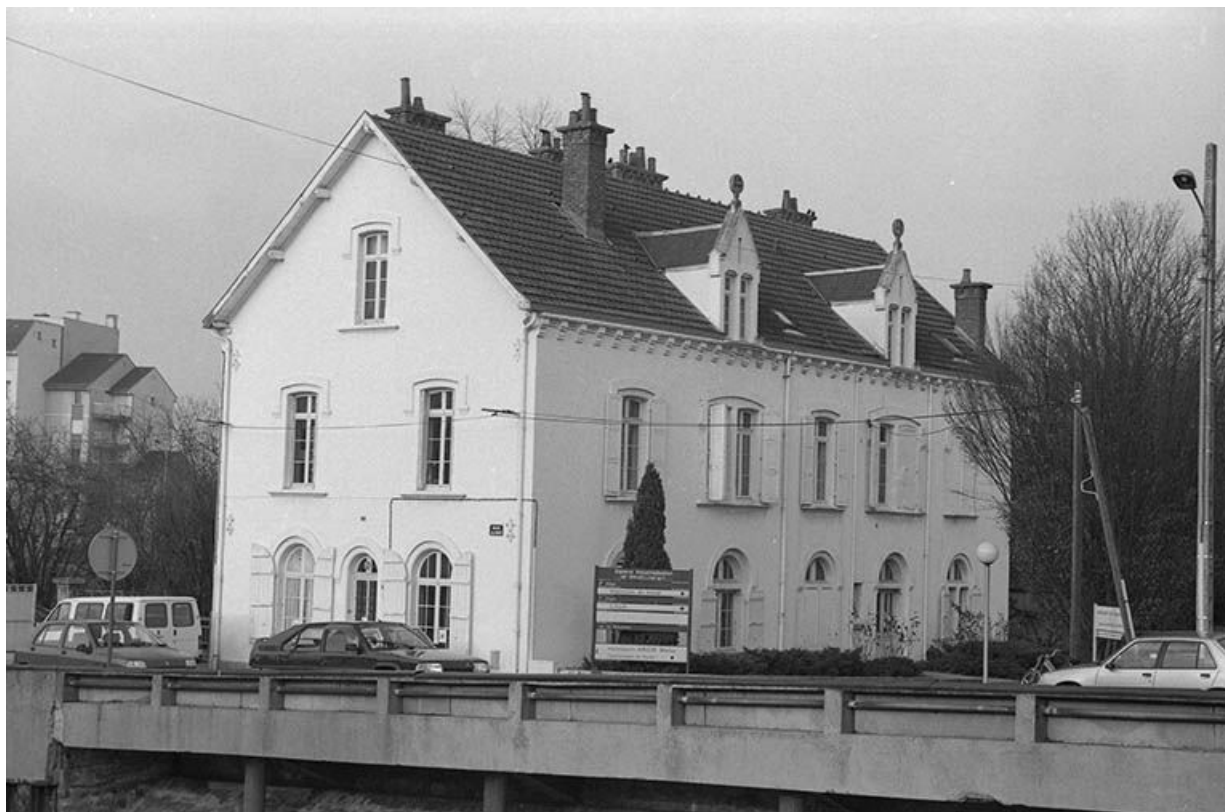
Ancien logement des frères maristes, vu depuis le canal.
