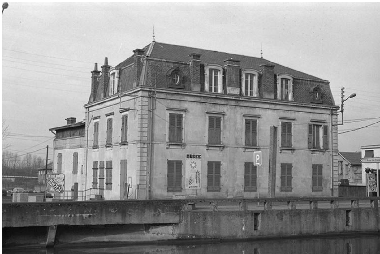
Logement d'ingénieur construit en 1847-50 : vue d'ensemble.
