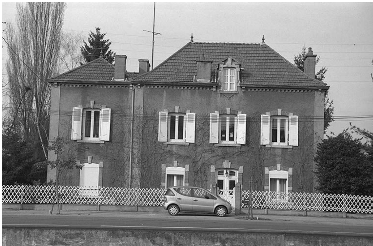
Logement de l'ingénieur des travaux extérieurs puis du chef des approvisionnements, construit en 1875 : vue d'ensemble. 71, Montceau-les-Mines, 76-90 quai Jules Chagot
