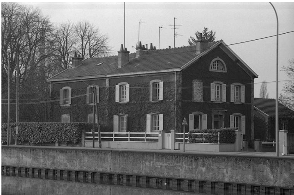
2 logements dont celui du directeur de la comptabilité, construits vers 1861 : vue d'ensemble. 71, Montceau-les-Mines, 76-90 quai Jules Chagot
