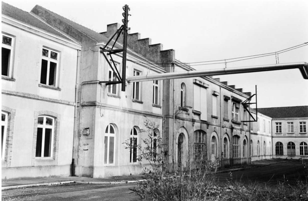
Anciens magasins 3 et 4 et atelier de réparation de 1865.
