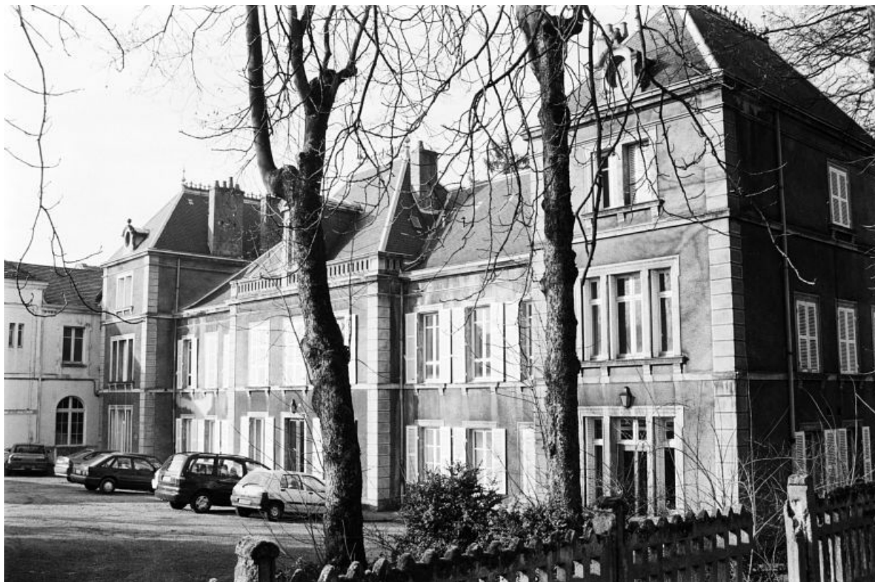
Façade antérieure de la " maison d'administration ".
