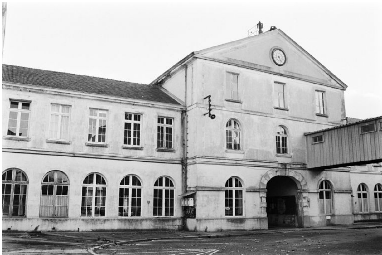
Façade postérieure des ateliers et bureaux centraux.
