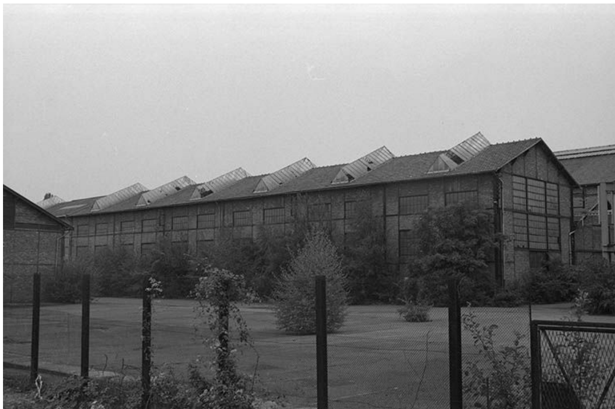
Entrepôt du premier quart du XXe siècle, vu de l'Est.
