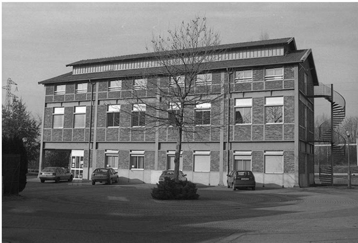
Magasin des modèles de fonderie puis service de construction (construit vers 1930), vu de l'Est. 71, Montceau-les-Mines quai Jules Chagot, lieudit : le Montceau
