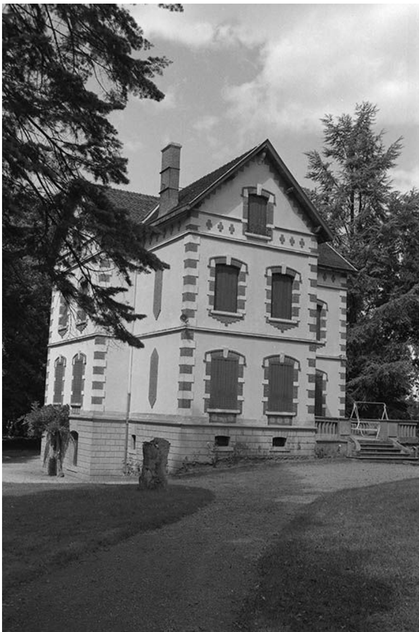
Ancien logement patronal dit " villa des Angliers " vu du Sud, façade antérieure. 71, Blanzly, 31-49 route de Montchanin, lieudit : les Angliers
