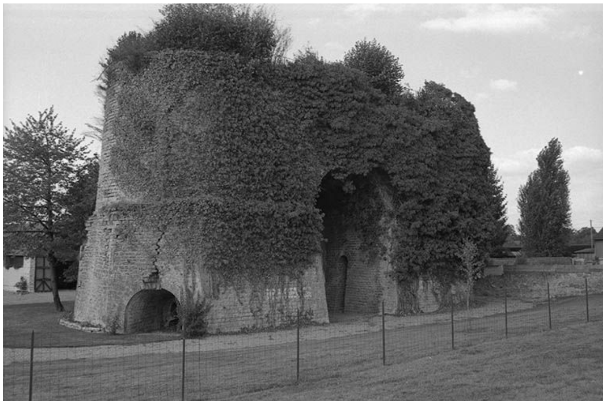
Fours à chaux de 1870 reliés par une arche donnant accès à l'orifice de défournement Sud du four de 1858.
