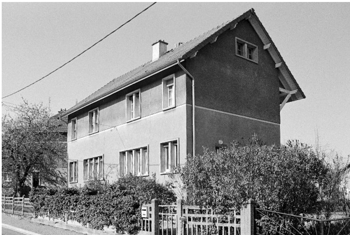
Bâtiment à 2 logements " type 16 rectifié ", toit à longs pans, 1946-1948.
