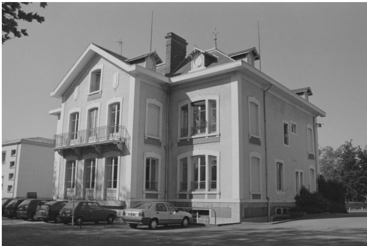
Façade antérieure du Château de Galuzot (1859-1863).
