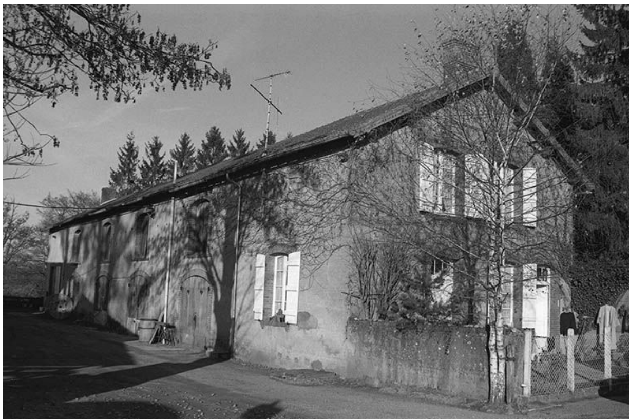
Ecuries et logement, vus depuis le canal.
