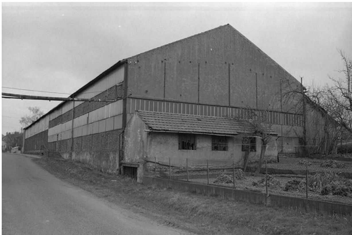
Ancienne chaudronnerie Prudhon acquise par les Ateliers de Constructions Mécaniques Aillot en 1937-39. 71, Montceau-les-Mines, 2 rue de Gilly
