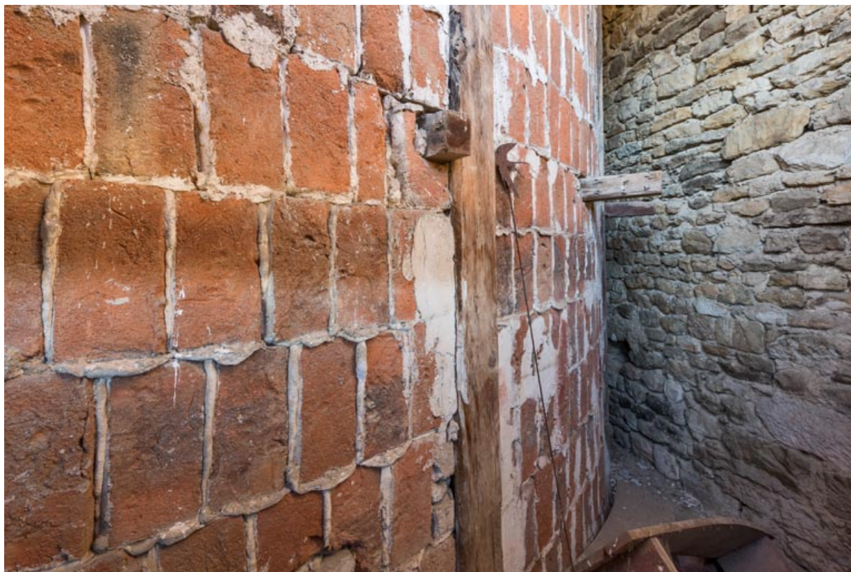
Théâtre : face arrière de la cloison formant le fond de la salle.
