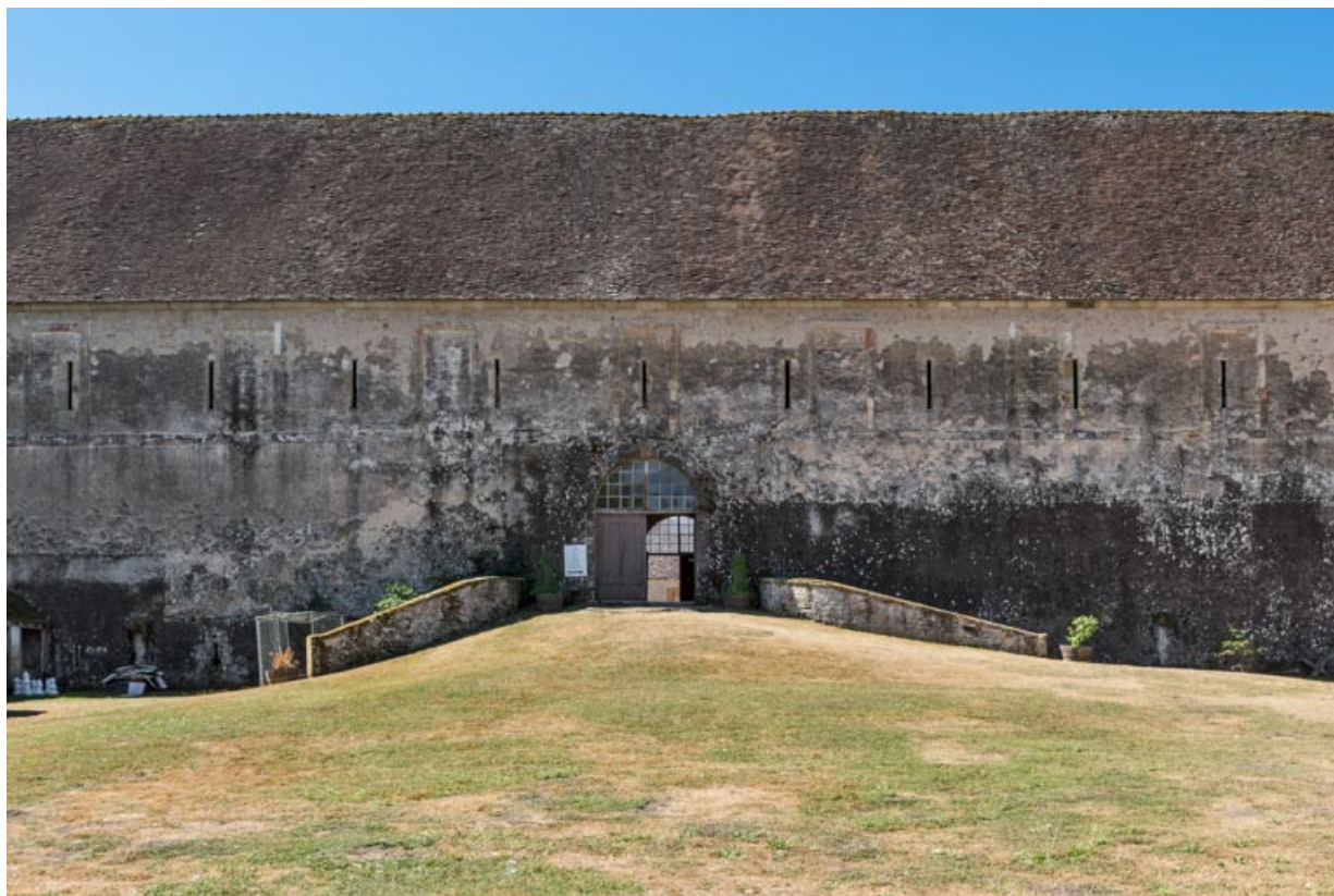
Façade postérieure : corps central.
