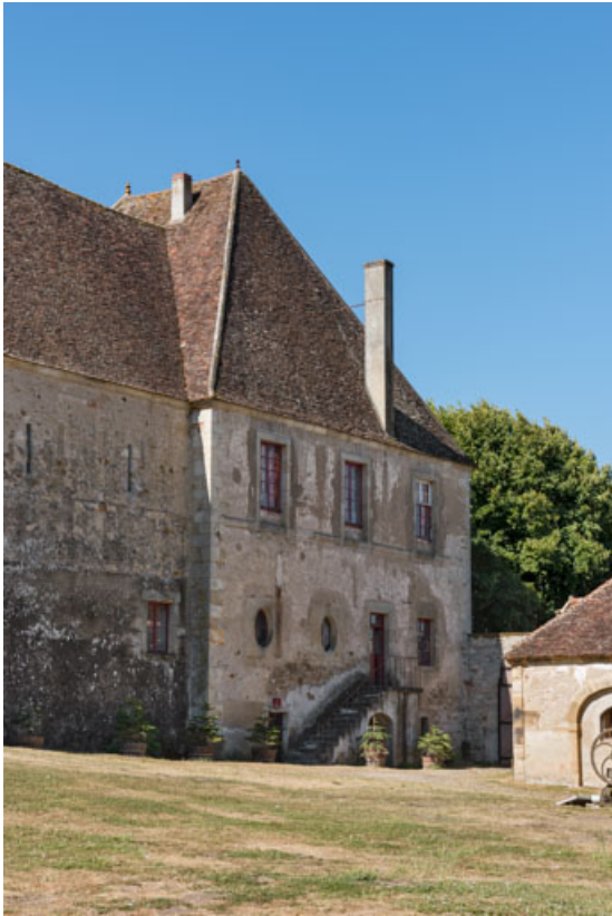
Façade postérieure : pavillon occidental.
