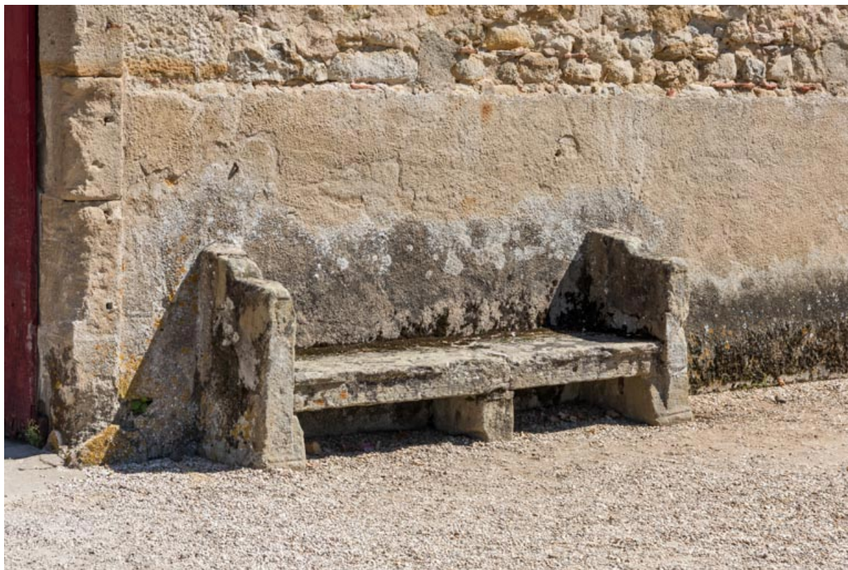
Façade antérieure : banc.
