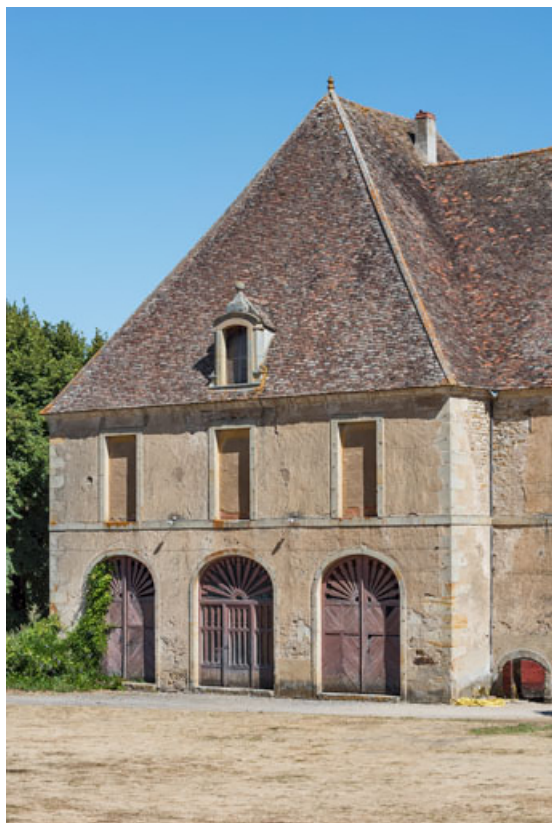
Façade antérieure : pavillon occidental (théâtre).
