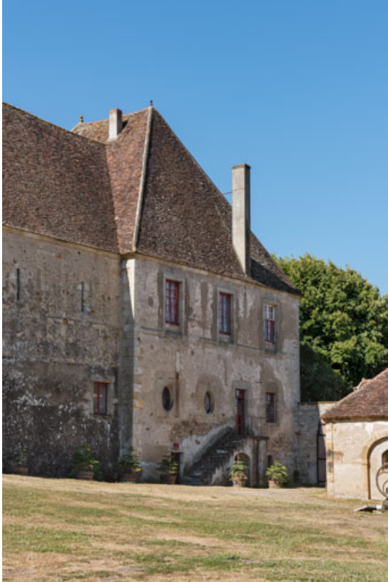
Façade postérieure : pavillon occidental.
