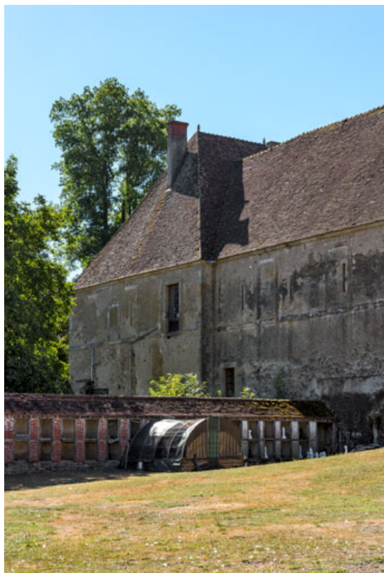
Façade postérieure : pavillon oriental.
