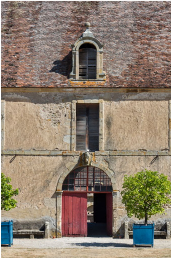
Façade antérieure : travée centrale.
