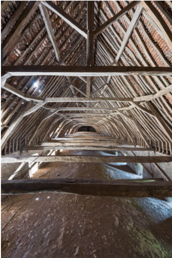
Ecurie, étage de comble : extrados de voûte et charpente. 71, Sully, 4 rue du Château
