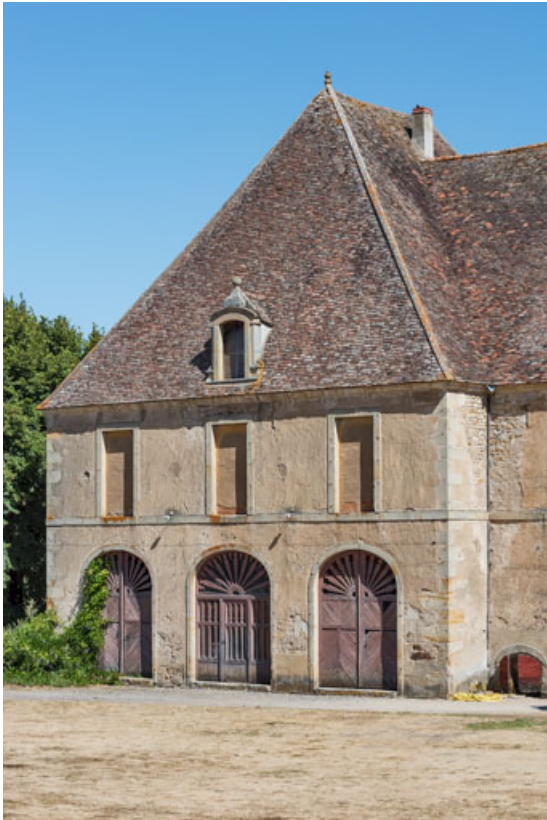
Façade antérieure : pavillon occidental (théâtre).
