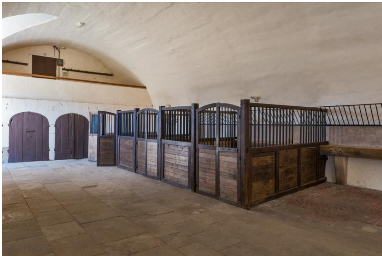
Ecurie, partie occidentale : stalles.
