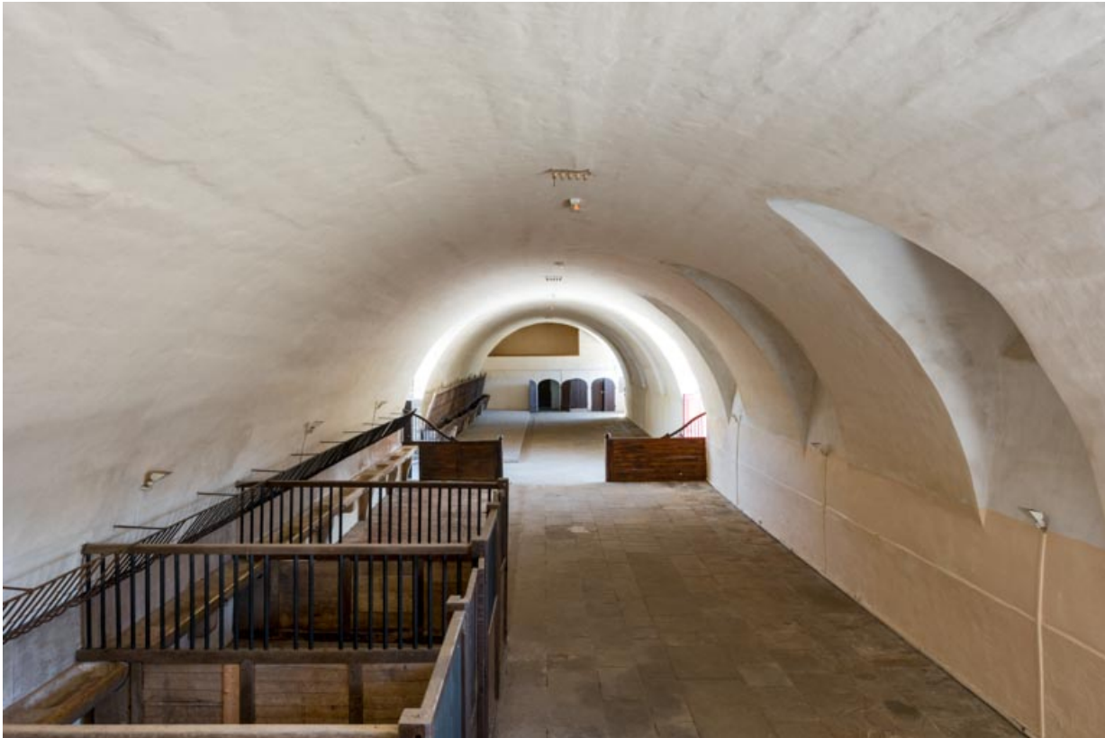
Ecurie : la voûte depuis la tribune occidentale.
