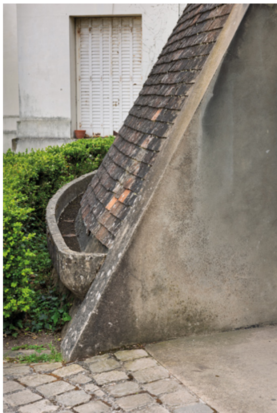
Jardinière à la base de la toiture.
