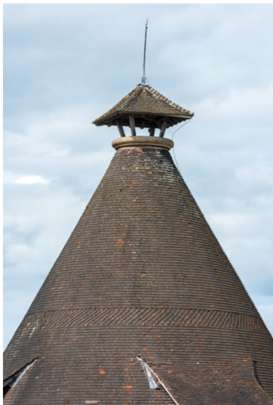
Toiture tronconique, avec oculus zénithal protégé par un petit toit en pavillon.
