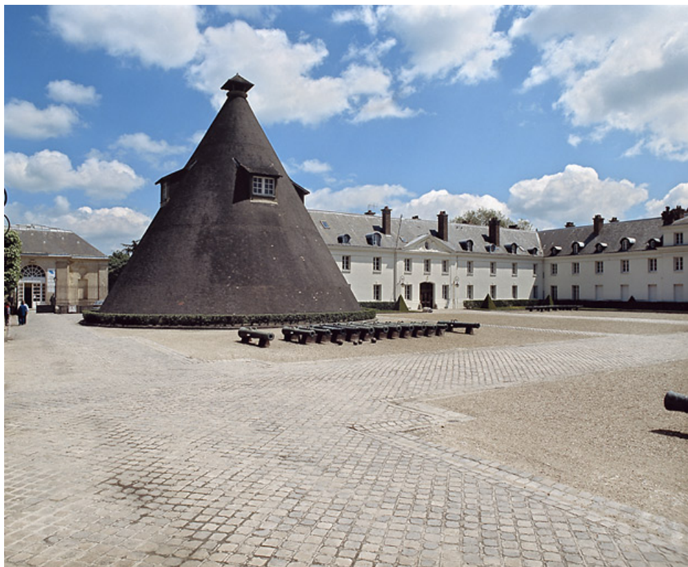
Vue extérieure de l'ancien four aménagé en théâtre.
