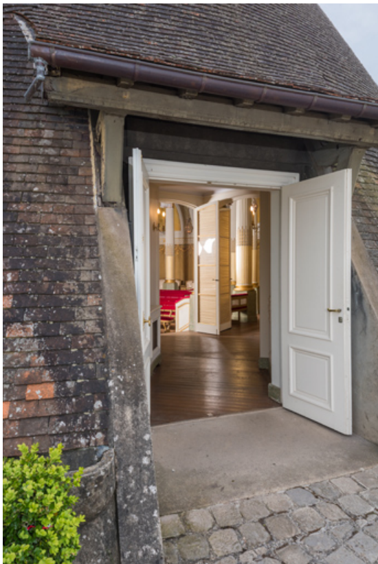
Entrée, côté nord-est.
