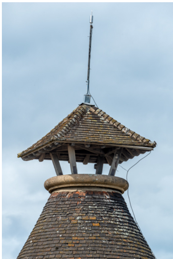
Toiture : petit toit en pavillon coiffant l'oculus zénithal.
